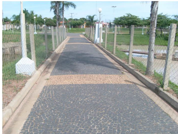
Corredor entre os dois reservatórios
