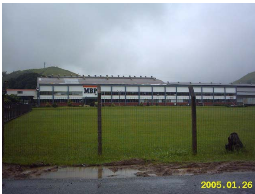
Figura 36 – A Metalúrgica Barra do Pirai – Vista Panorâmica.
