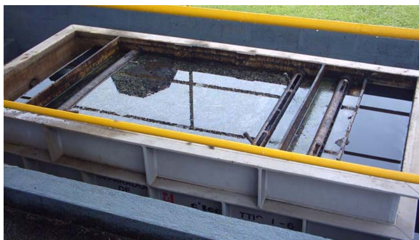
Figura 42 – Separador Água-Óleo.
