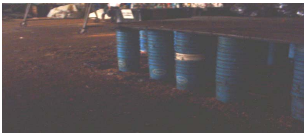
Figura 32 – Detalhe do Piso do Galpão.
