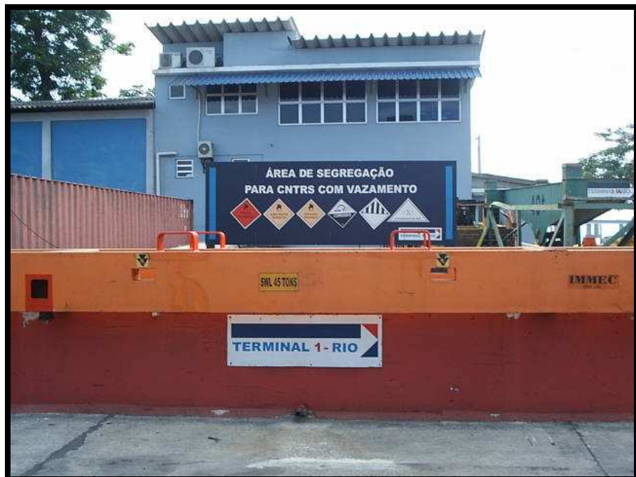
Figura 4.4 - Tanque para armazenamento de contêineres com vazamentos
