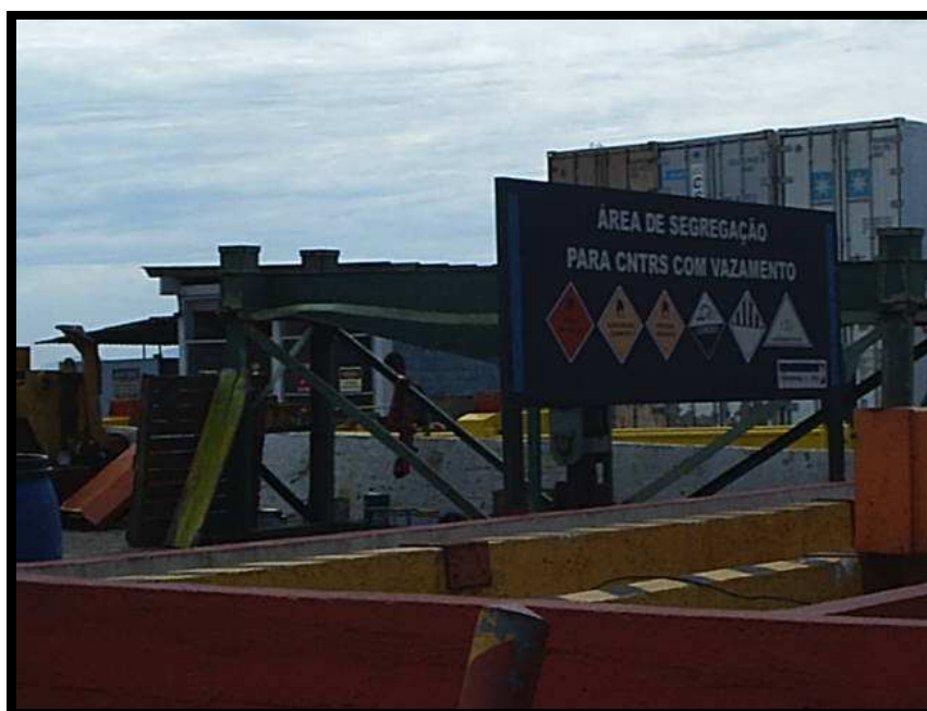
Figura 4.9 - Área de armazenamento de contêineres com vazamentos
