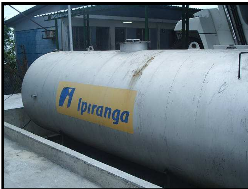
Figura 4.8 - Tanque de armazenamento de combustíveis
