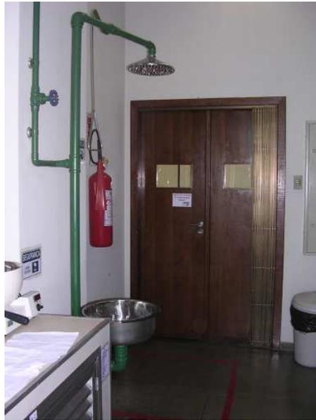
**Figura 22:** Detalhe do chuveiro de descontaminação
