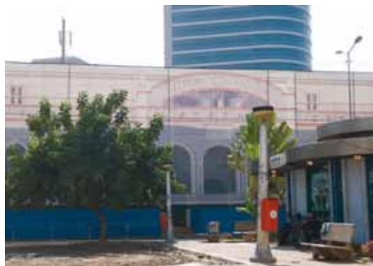
Fig. 35 – Prédio (em reforma) dos Correios, Luanda, 2008
