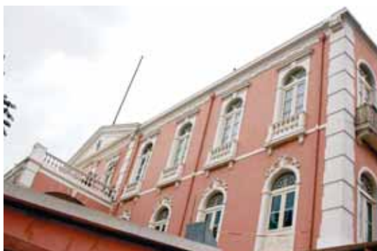
Fig. 86 – Câmara Municipal do Governo (construída entre 1890-1911), Luanda, 2008
