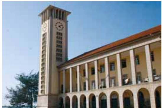
Fig. 91 – Edifício da Alfândega, Luanda, 2008
