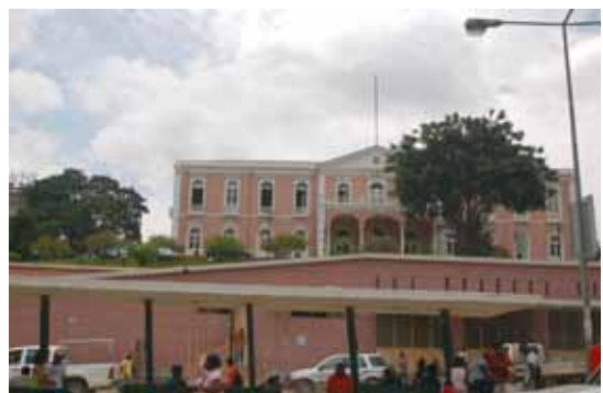
Fig. 87 – Câmara Municipal do Governo (construída entre 1890-1911), Luanda, 2008
