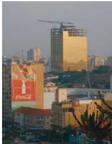
Fig. 92 – Edifícios em construção, Luanda, 2008
