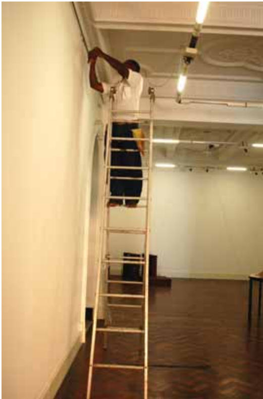
Fig. 313 — Espaço 1 — Sr. Valmir (funcionário do ICBA), colocação dos cabos de aço.
