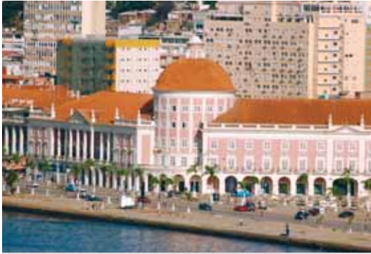
Fig. 88 – Banco Nacional de Angola (construído em 1956), 2008
