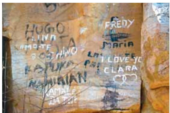
Fig. 76 – DETALHES de muros, Luanda, 2007
