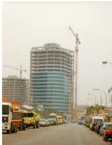
Fig. 93 – Edifícios em construção, Luanda, 2008
