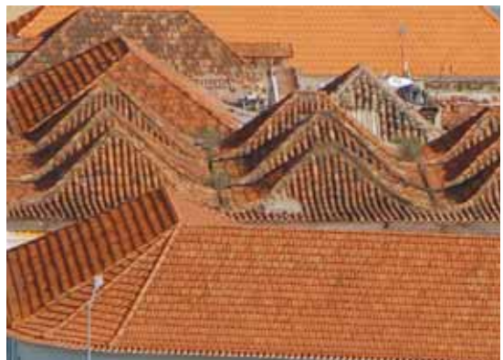
Fig. 33 – Detalhe, construção com telhados múltiplos, Cidade Baixa, Luanda, 2008
