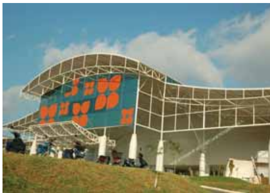
Fig. 104 — Belas Shopping, construído pela Empresa Odebrecht, Luanda, 2008
