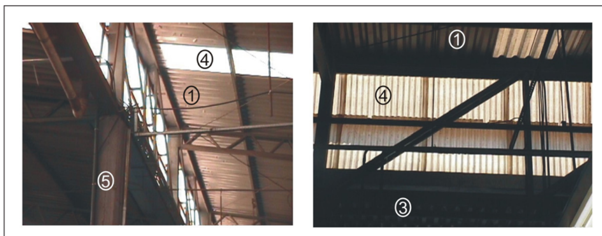
Figura 18 – Estruturas metálicas e cobertura com telhas de zinco e policarbonato
