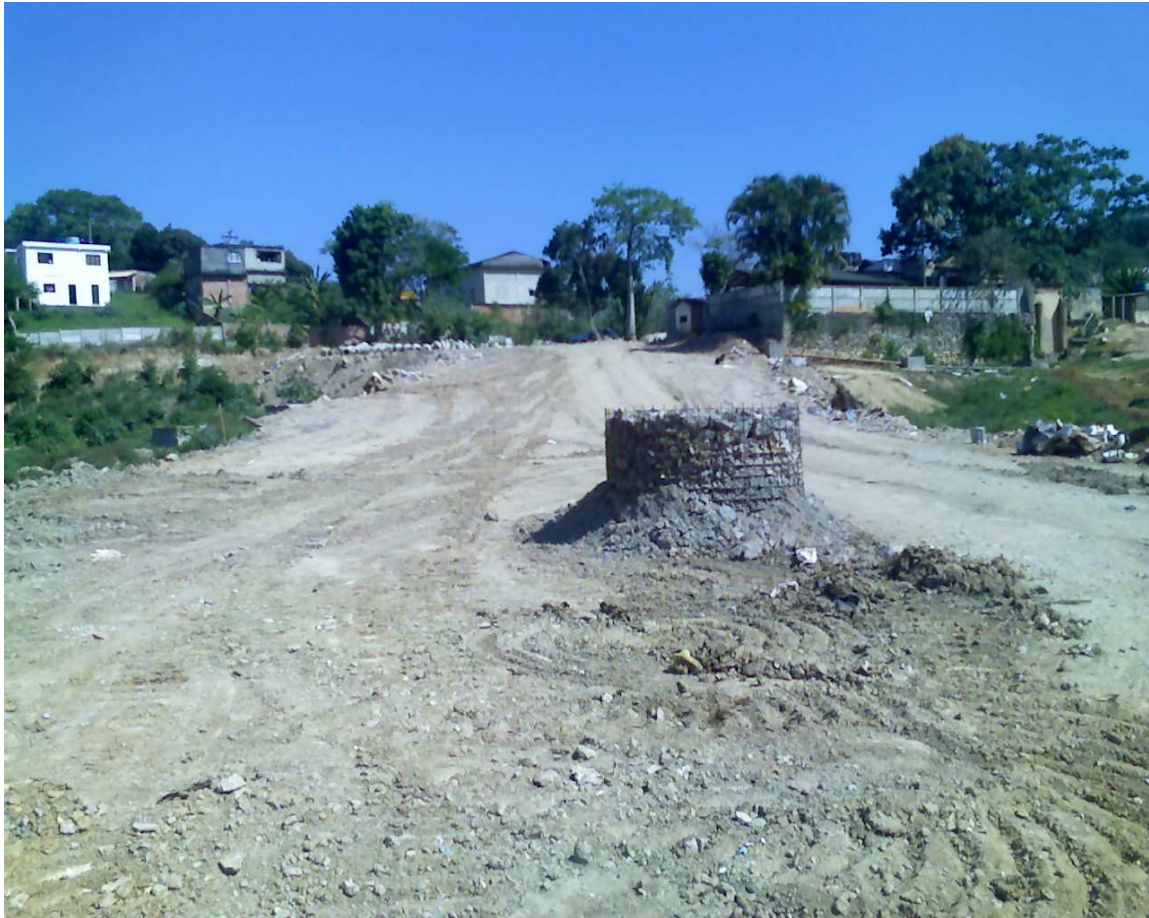
Figura 10 – Adequação dos drenos de gás existentes.
