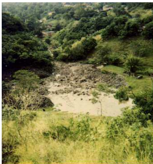
Figura 3. Vista de talude rompido (do alto do aterro – 1994)
