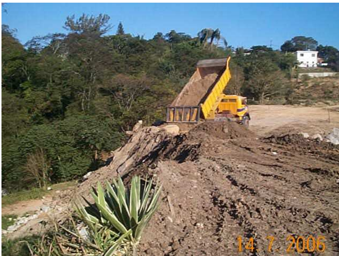
Figura 9 – RCC sendo utilizado na execução da berma de equilíbrio no ACMC.
