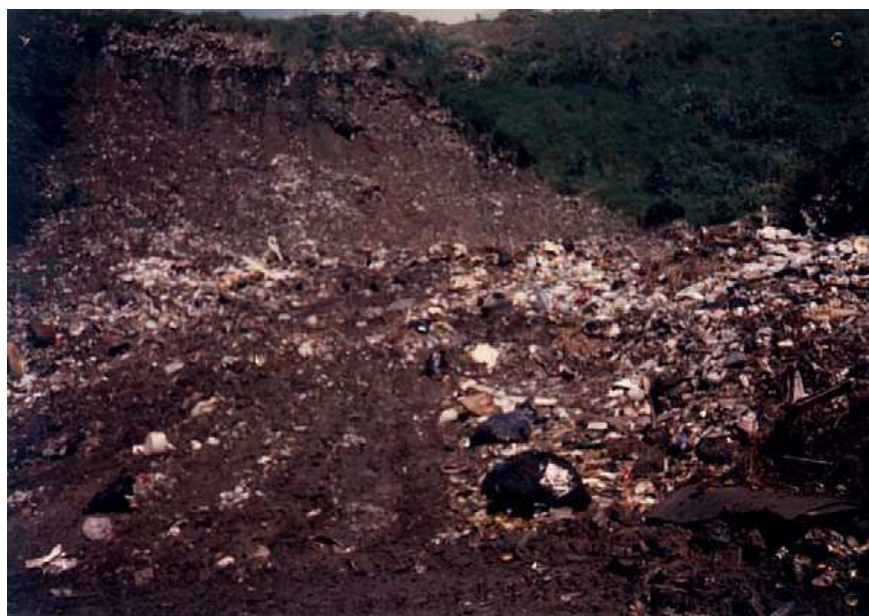
Figura 3. Vista de talude rompido (do alto do aterro – 1994)
