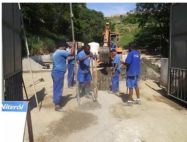
Figura 7 – Implantação da rede coletora de chorume do ACMC pela “Águas de Niterói”
