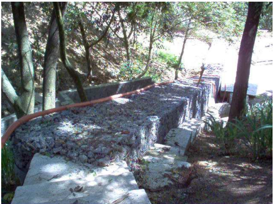
Figura 16 – Muro de gabião na base do ACMC.
