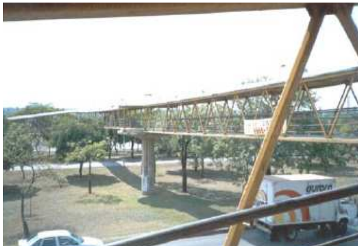
Figura 2.8 - Trecho horizontal da passarela sobre a via EPIA.
