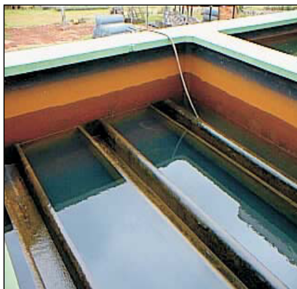
Figura 2.14 - Filtro lavado. Fonte: Reali (1999)
