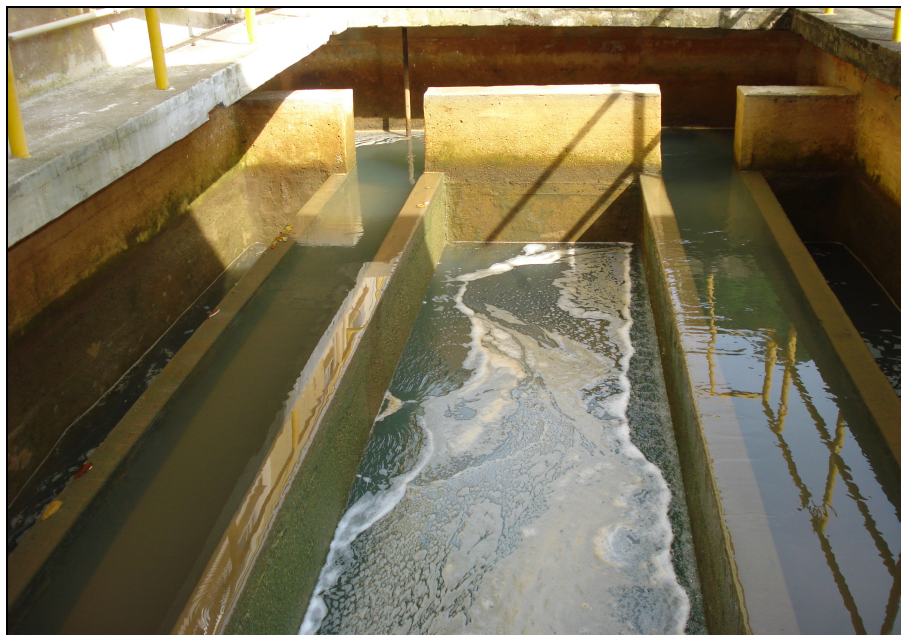
Figura 2.11 – Filtro rápido em carga. Fonte: Arquivo do Autor (2006).
