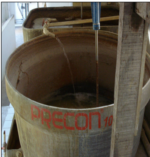
Figura 6.17 - Lavagem do tanque de sulfato. Fonte: Arquivo do Autor (2007).
