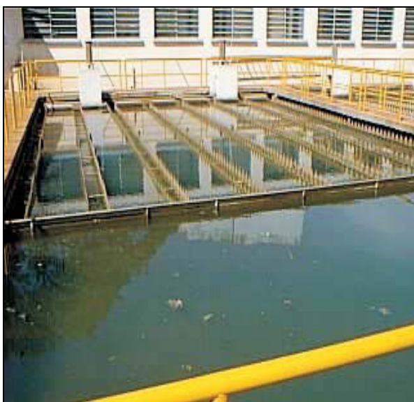
Figura 2.15 – Decantador fora de carga. Fonte: Reali (1999).
