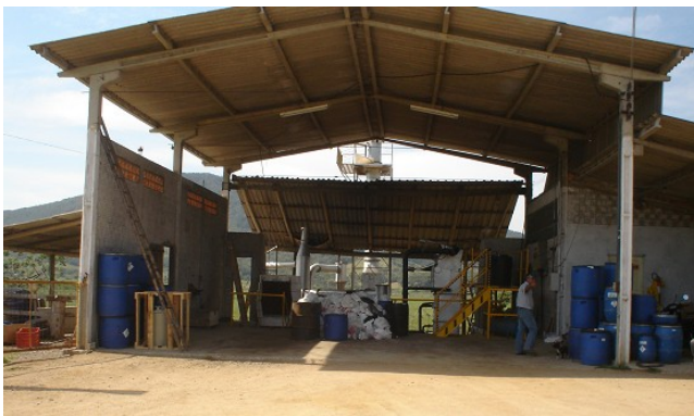
Foto 1 - Instalações do incinerador de resíduos.
