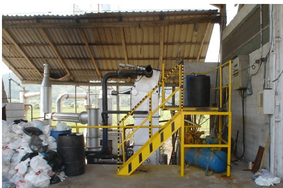
Foto 3 - Incinerador de resíduos – acesso principal.
