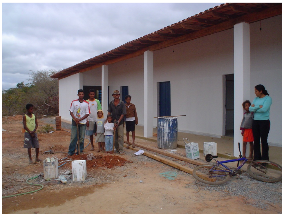
FOTO 16: Obra de ampliação da escola local.
