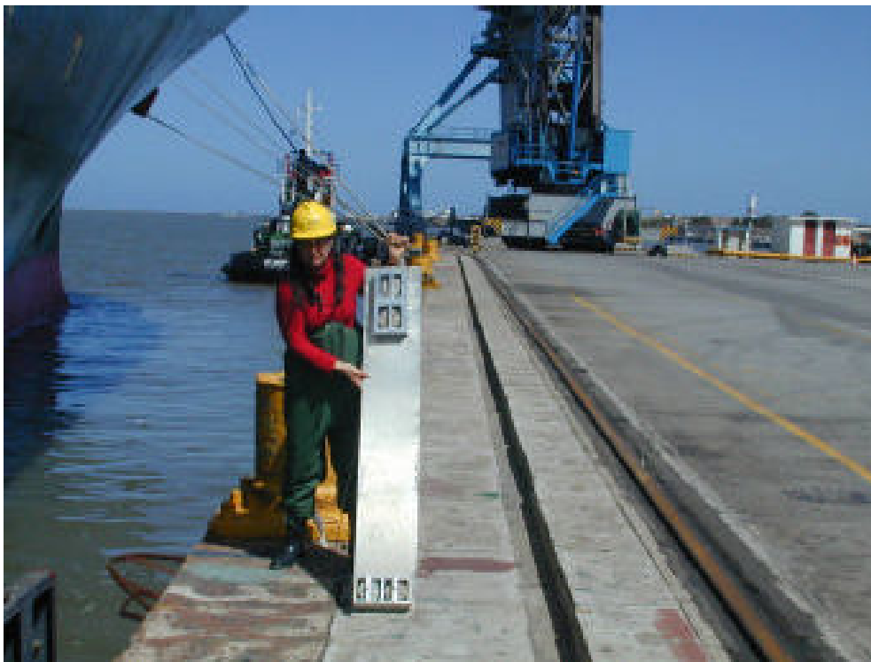
Figura 7.3 - Retirada para pesagem dos testemunhos do paramento do cais do TECON (BRETANHA, 2004)
