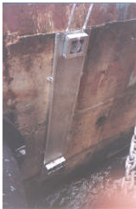
Figura 7.4 - Testemunhos posicionados no paramento do cais (BRETANHA, 2004)
