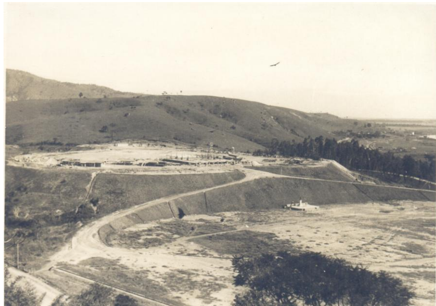
Figura 9 – Foto da Morro das Pitas – Serviço de Terraplanagem Fonte: Arquivo Centro de Documentação e Memória do Santuário Nacional de Nossa Senhora Aparecida
