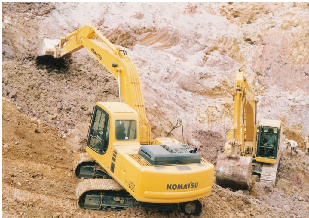
Ilustração 1: Escavações no garimpo através de retro-escavadeiras – Garimpo da Baixa. Fonte: Acervo da família do sr. Lourival Moreira Damasceno, 2003.
