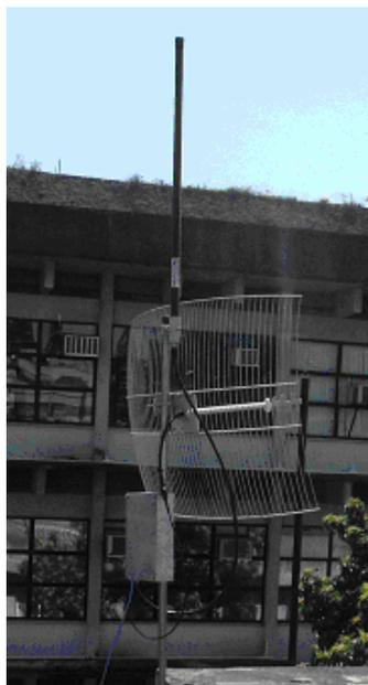
Figura 28: Nó da UFF com as duas antenas instaladas (direcional e omni)
