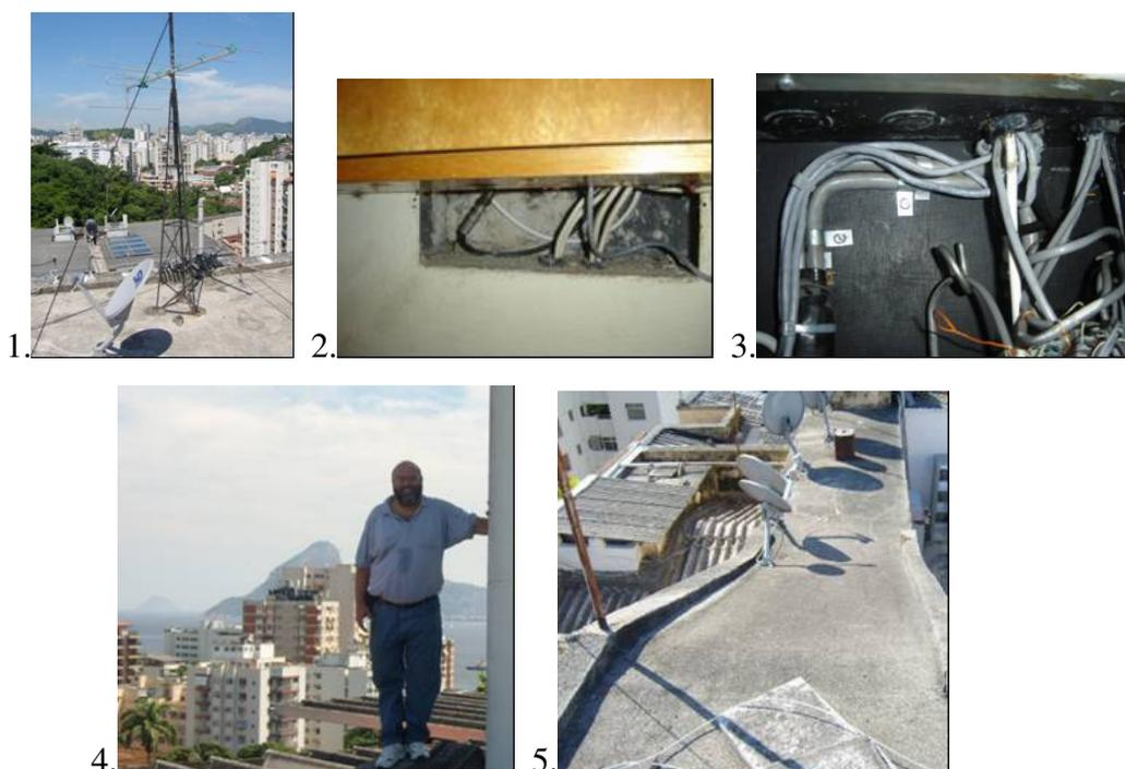
Figura 23: Vistoria da viabilidade de instalação do protótipo externo em diferentes prédios: 1. Presença de antenas interferentes; 2. Acesso até o apartamento do voluntário; 3. Viabilidade de passagem dos cabos; 4. Presença de linha de visada para outro ponto; 5. Espaço físico com condições de perfuração do chão
