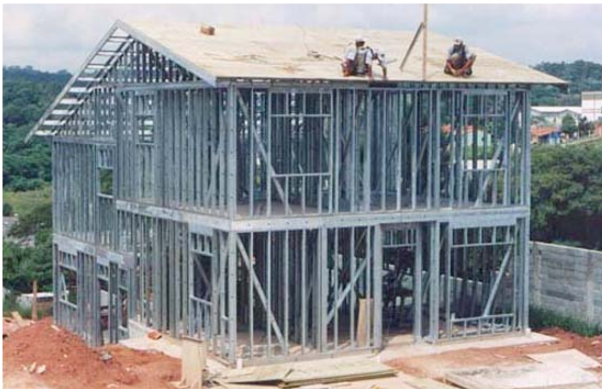
Figura I. 3 – Estrutura da casa montada (Fonte: www.revistaau.com.br )
