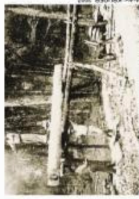
Foto 2 - Produção de tábuas com serra manual, movida a força humana, na Fazenda São Pedro, em Cambói, em 1956.
