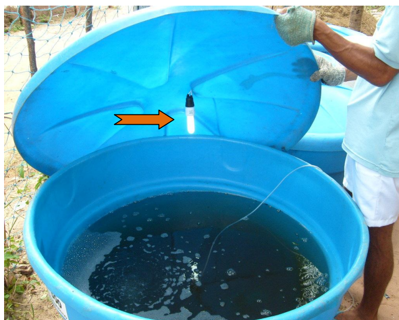
FIGURA 3: Caixa d'água mostrando a lâmpada fluorescente de 11W na tampa (seta).
