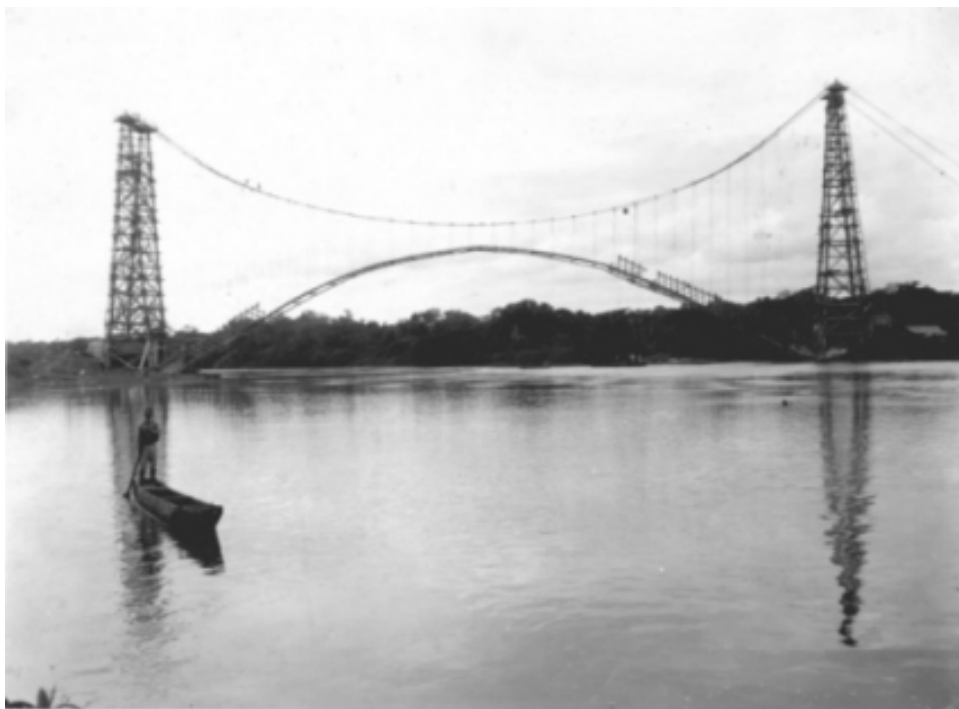
Figura 17 – Construção da Ponte Novo Oriente
