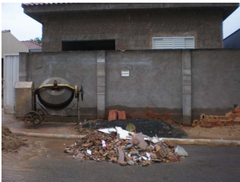
Figura 213. RCD de construção nova na Rua Armando Domingues em Palmares Paulista FONTE: AUTOR (2009)
