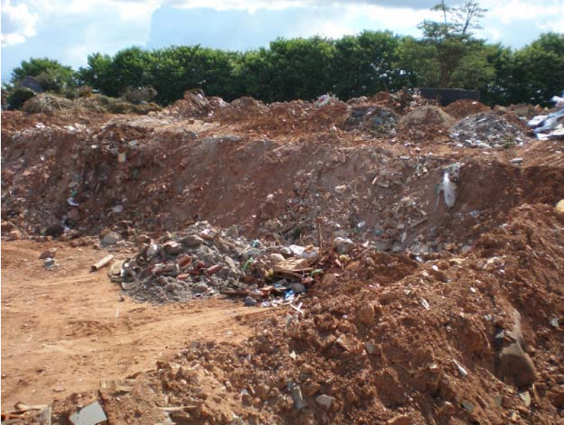
Figura 324. Deposição de RCD no aterro de inertes da Mejan Ambiental em Votuporanga
