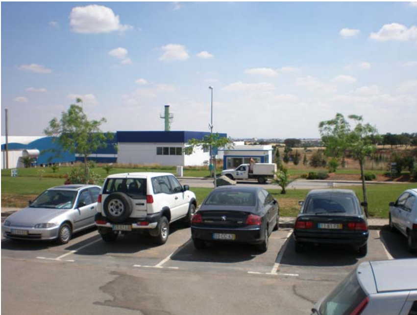
Figura 44. Unidade de tratamento de resíduos hospitalares
