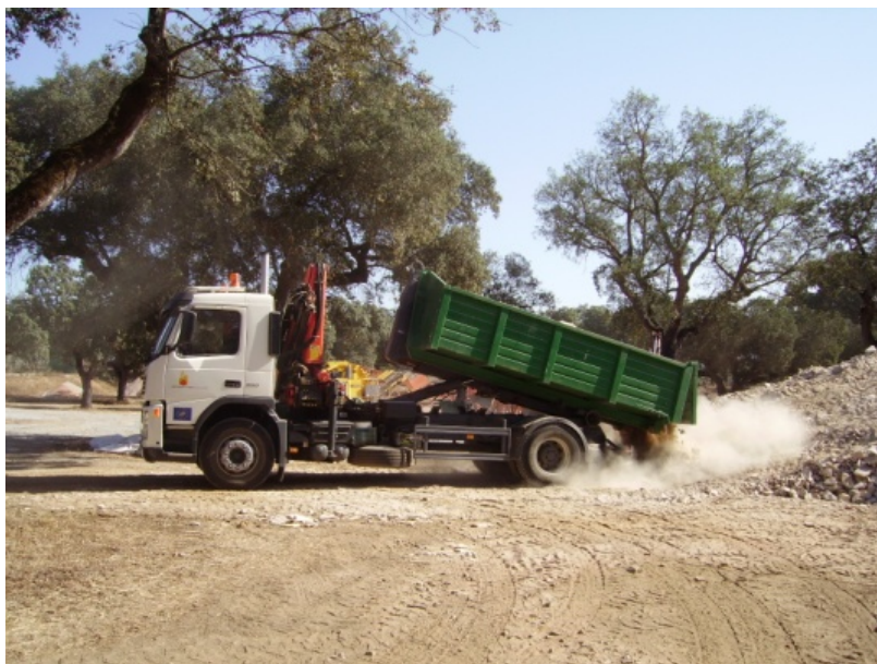
Figura 32. Descarga do caminhão de recolha na área de armazenamento
