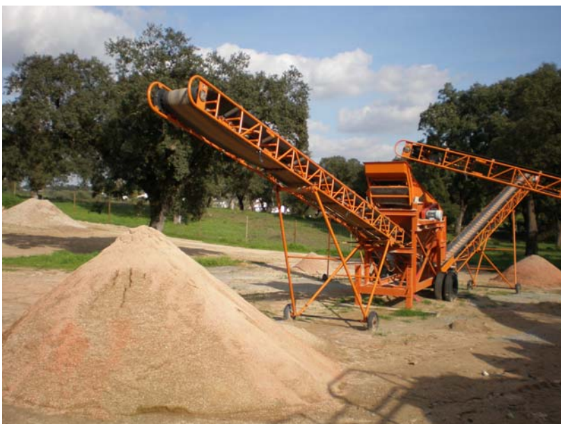
Figura 36. Detalhe dos agregados reciclados após beneficiamento dos RCD FOTO: AUTOR (2007)
