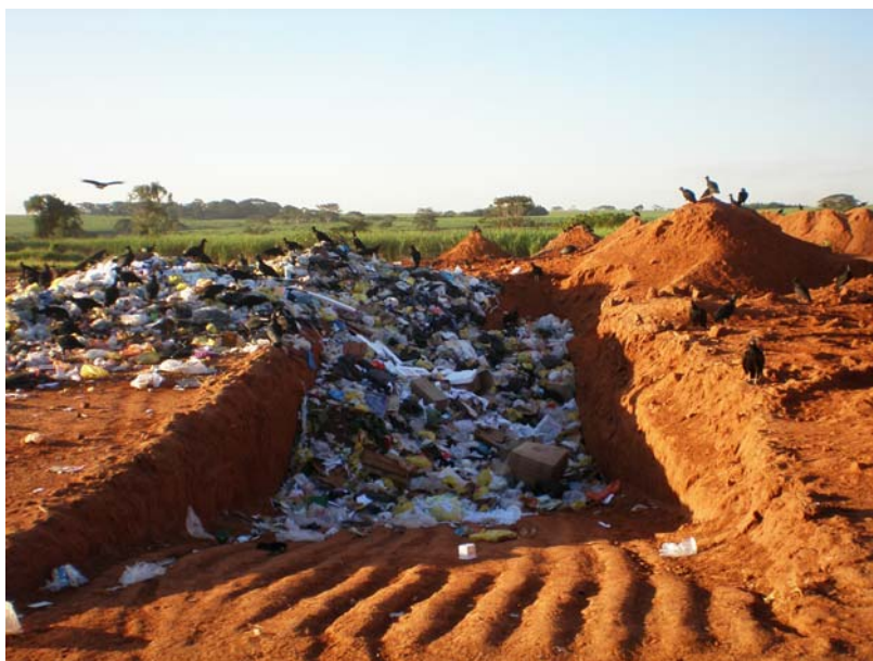
Figura 228. Aterro em vala de Paulo de Faria
