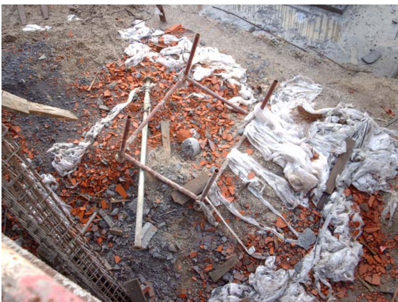
Figura 332. Detalhe da situação do canteiro com relação aos RCD em março de 2007
