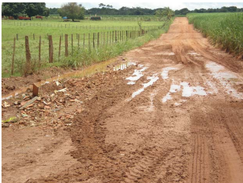
Figura 248. Uso do entulho na correção da estrada de acesso a Usina Gariropa
