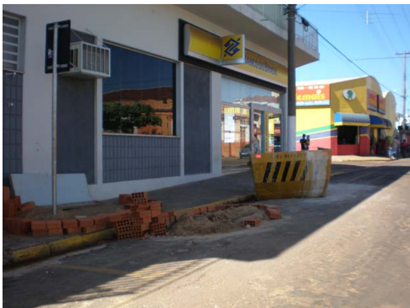
Figura 210. Caçamba de entulho da empresa privada de Palestina
