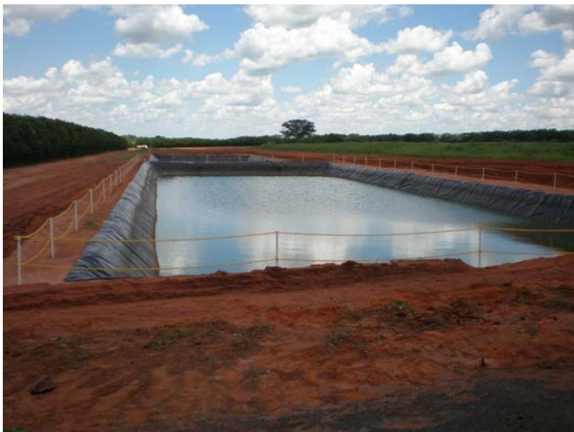
Figura 175. Lagoa de chorume do aterro sanitário da Constroeste em Mirassol
