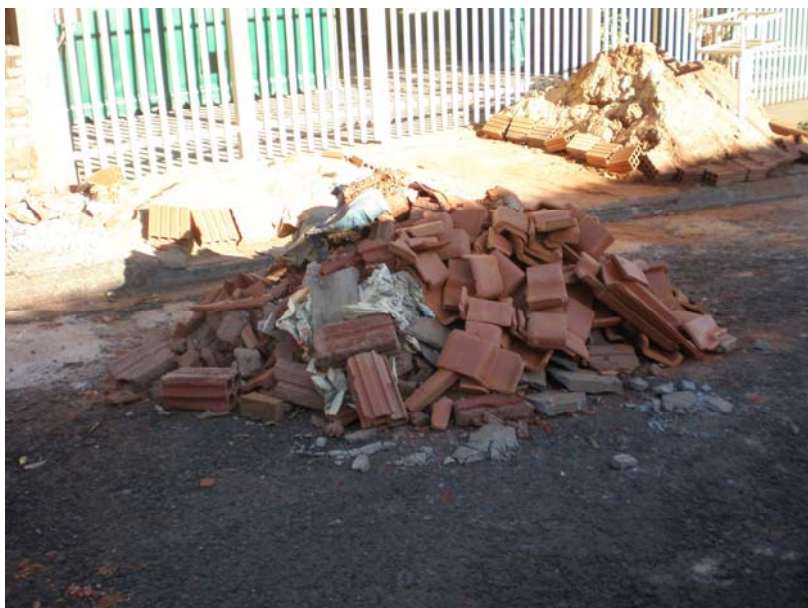
Figura 157. Entulho de reforma deixado na Rua Siqueira Campos em Ipiruá
