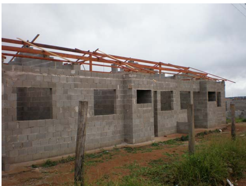
Figura 49. Detalhe dos blocos da Prohab utilizados em obra de interesse social FOTO: AUTOR (2008)
