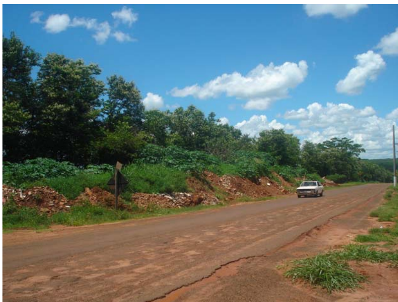
Figura 169. Depósito de RCD na Rodovia Mesópolis-Populina
