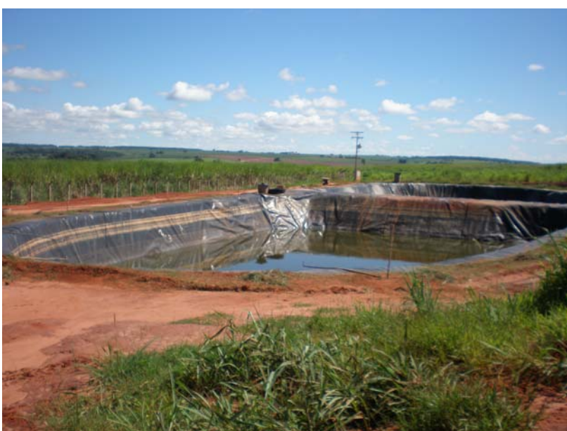
Figura 146. Lagoa de tratamento de chorume do Aterro Sanitário da Proposta Ambiental
