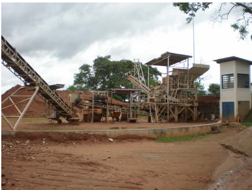
Figura 277. Central de reciclagem de entulho de São José do Rio Preto
