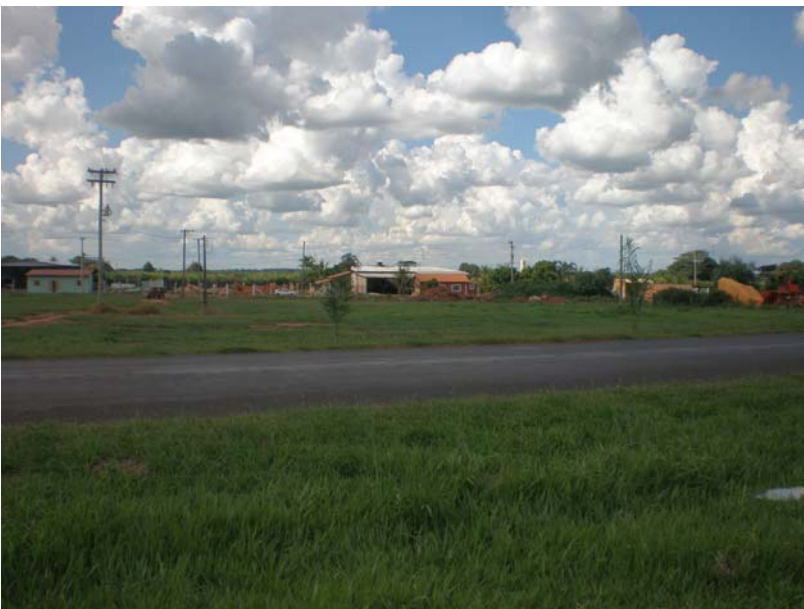
Figura 318. Área de deposição de RCD em Vitória Brasil
