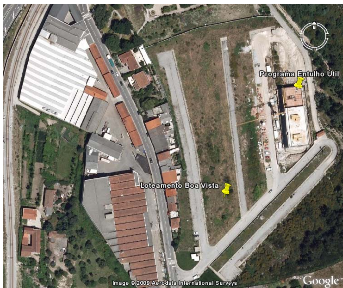
Figura 330. Imagem por satélite da obra em Guimarães, Portugal
