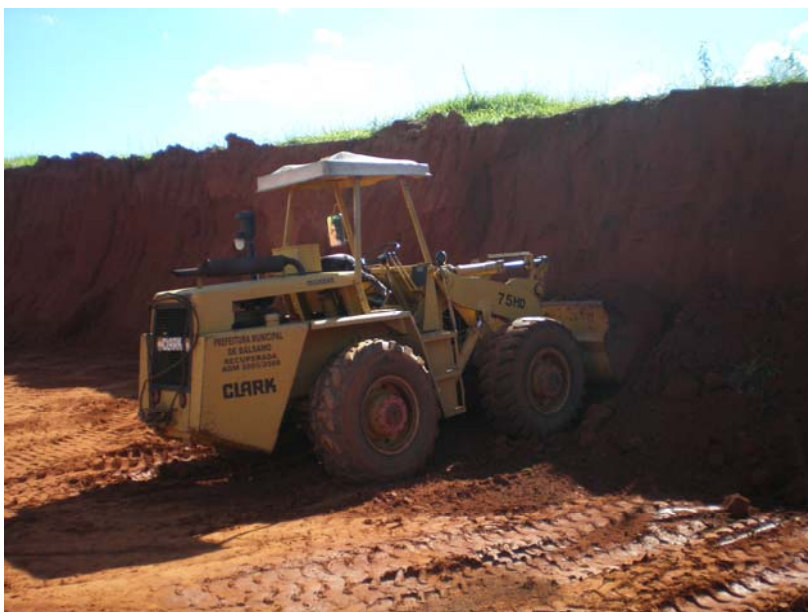
Figura 110. Pá carregadeira retirando solo para uso em obras de Bálamo FOTO: AUTOR (2009)
