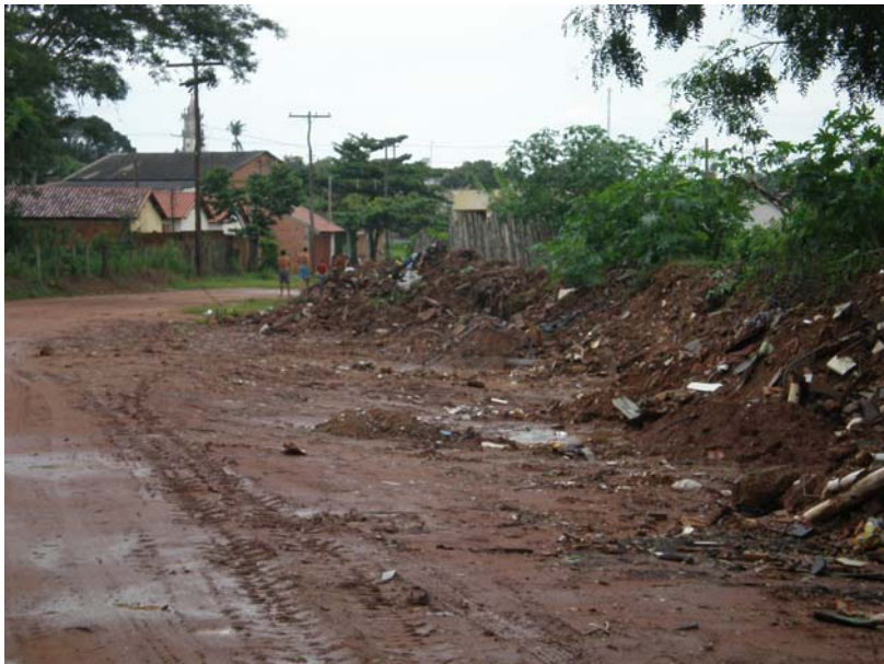
Figura 295. Local de armazenamento de entulho no município de Taiúva
