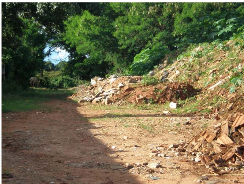
Figura 311. Área de disposição de RCD de Urânia junto ao cemitério municipal
