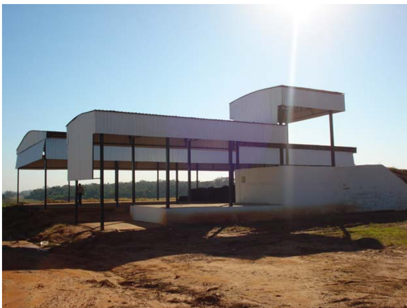
Figura 313. Usina de reciclagem e compostagem de lixo de Valentim Gentil
