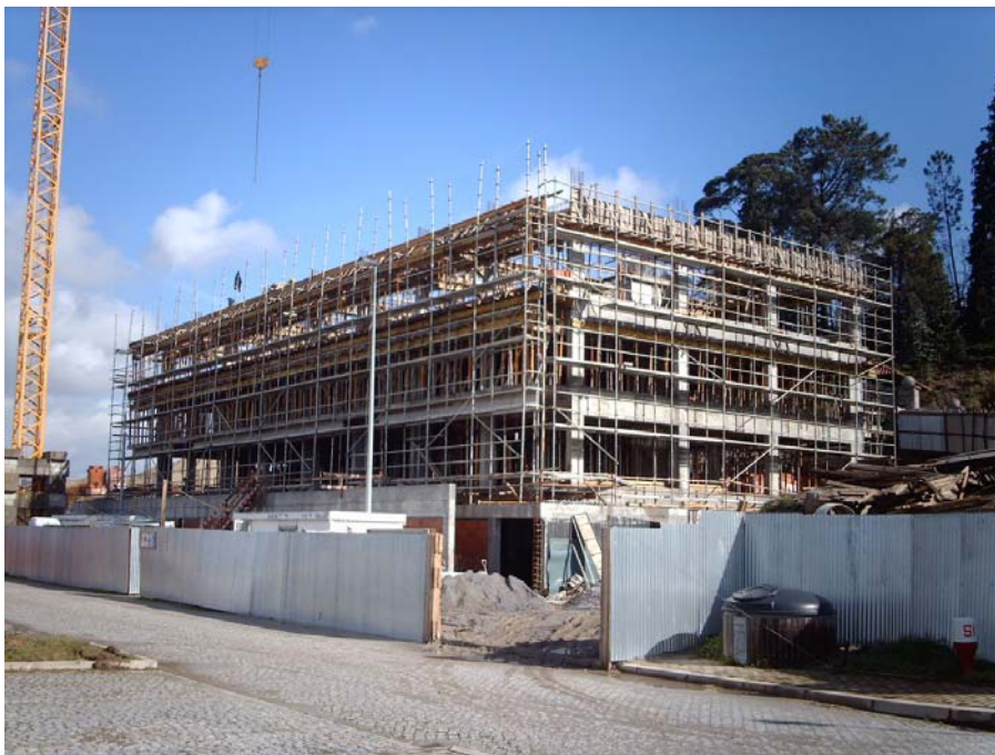
Figura 331. Edifício em Guimarães no qual foi implantado o Programa Entulho Útil FOTO: AUTOR (2007)
