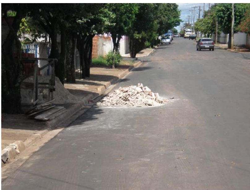
Figura 113. RCD na Rua João Geraldo próximo a praça central de Cajobi
