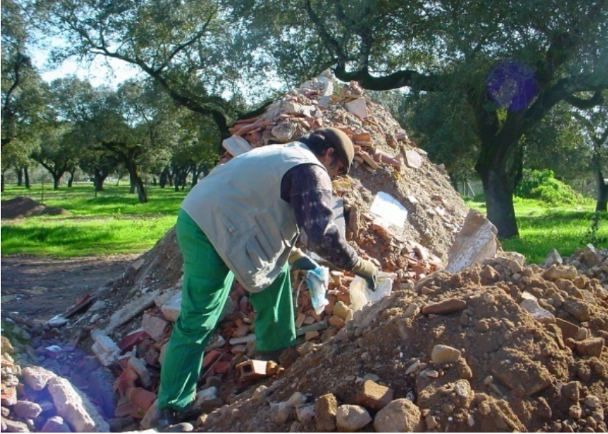
Figura 33. Separação manual dos resíduos para beneficiamento FOTO: ENG a CÂNDIDA MARTINS (2007)
