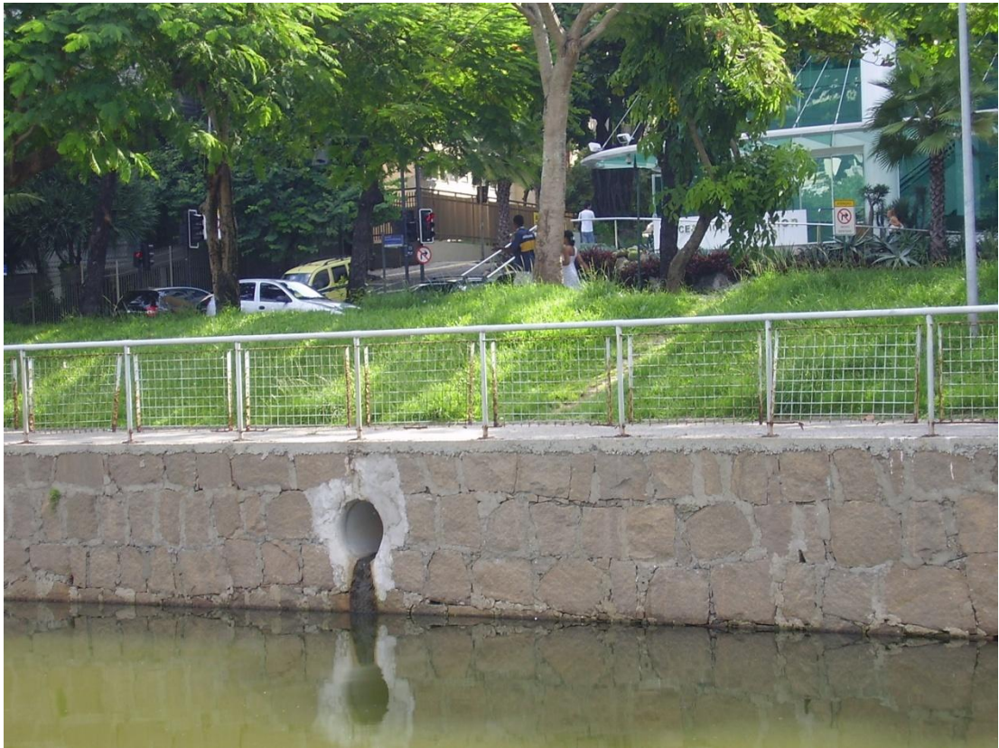
Figura 6.13 - Aporte de águas pluviais no trecho em frente ao Shopping Leblon.
