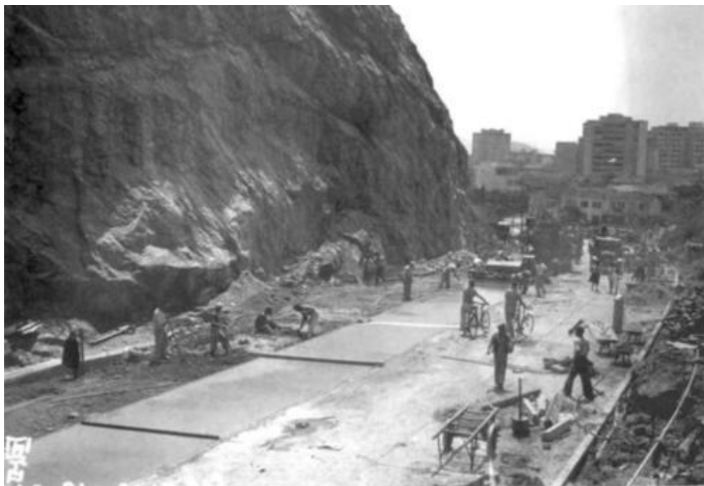
Figura 4.8 - Construção do Corte de Cantagalo.
