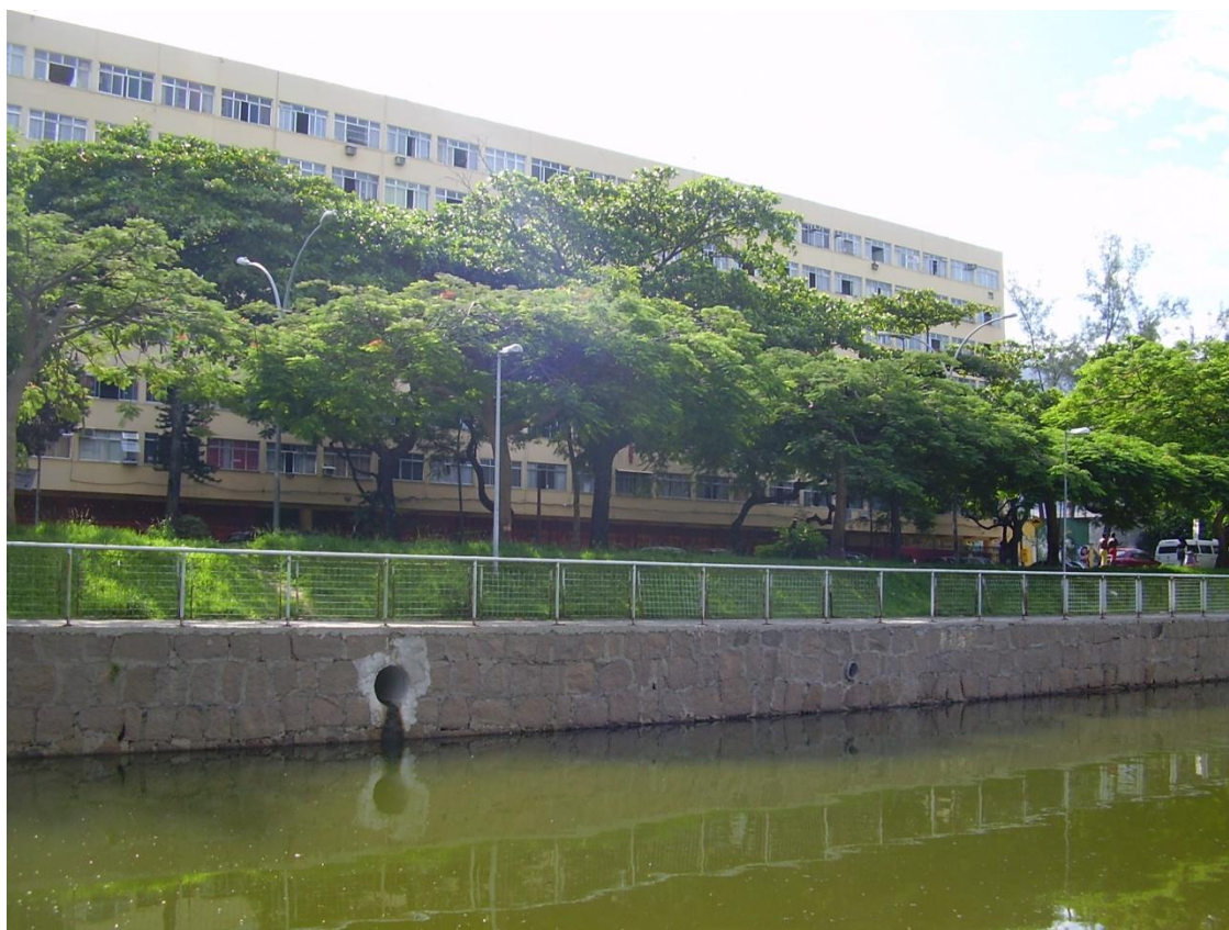
Figura 6.14 - Aporte de águas pluviais no trecho em frente à Cruzada São Sebastião.
