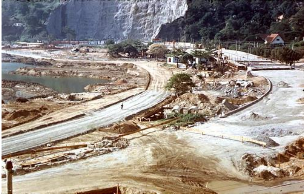
Figura 4.9 - Construção do viaduto Augusto Frederico Schmidt, década de 1960.
