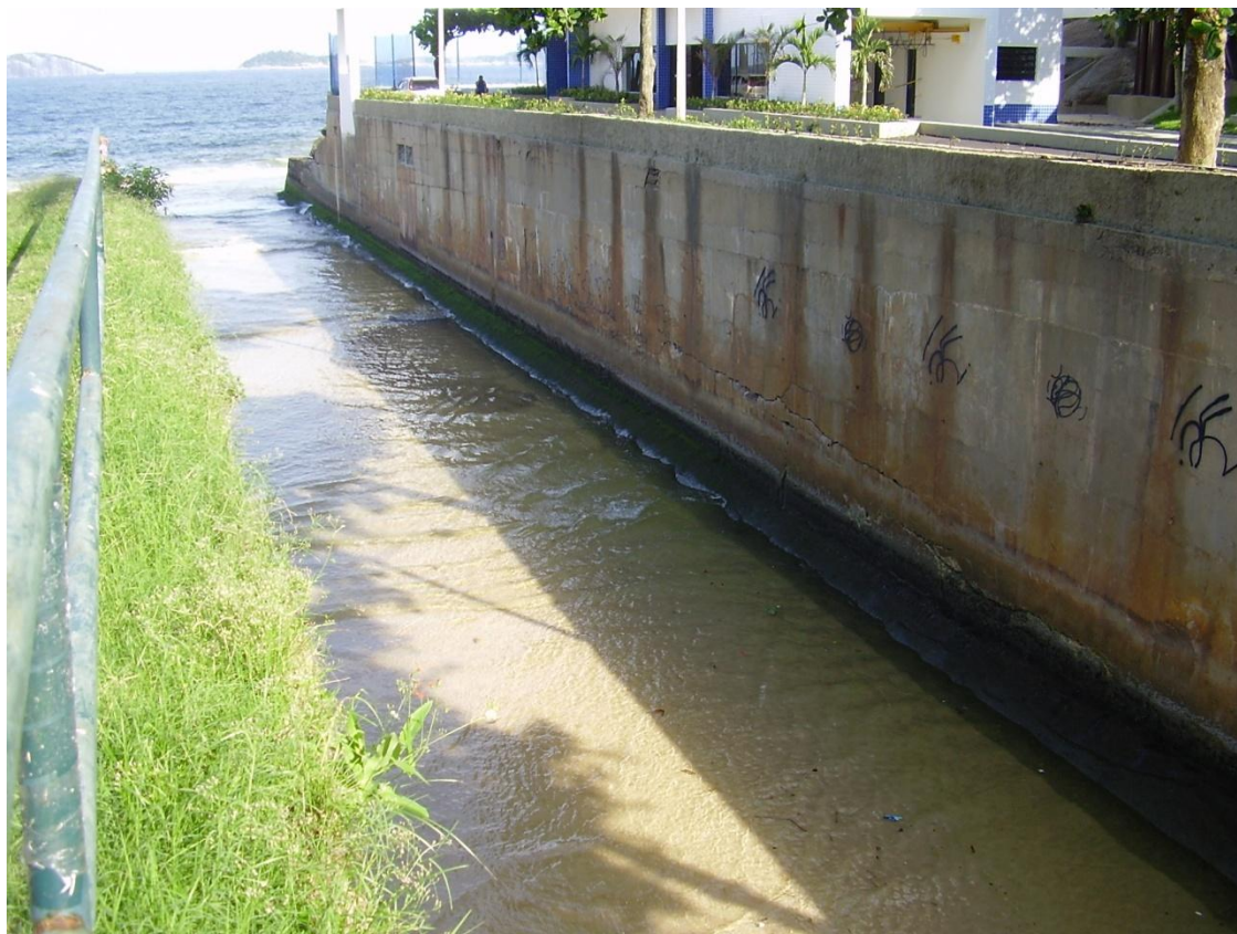
Figura 6.17 - Saída do Canal da Av. Visconde de Albuquerque na Elevatória de esgoto Leblon.
