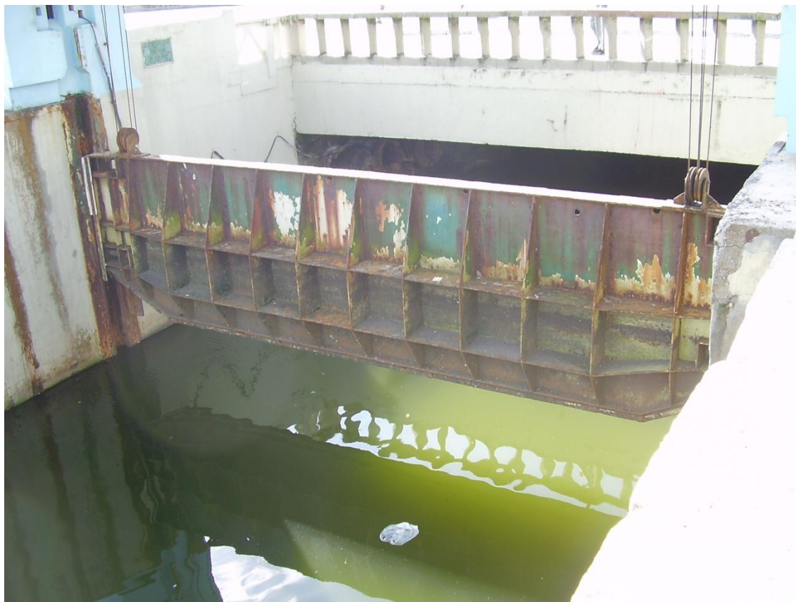
Figura 6.11 - Comporta do Canal do Jardim de Alah.
