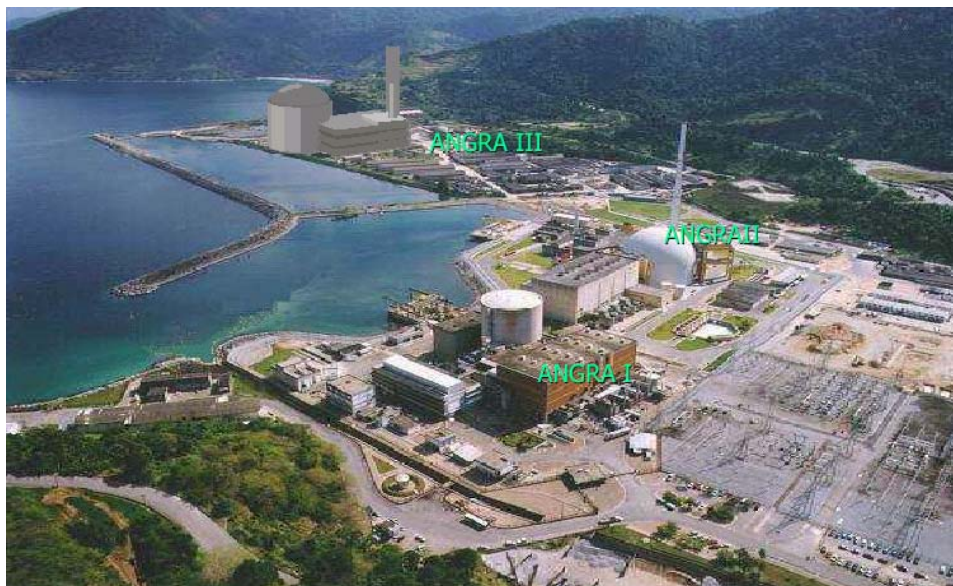
Figura 3.15: Foto aérea do Complexo Nuclear de Angra 1 e 2, e com a montagem de onde ficará localizada Angra 3 (Fonte ELETRONUCLEAR).
