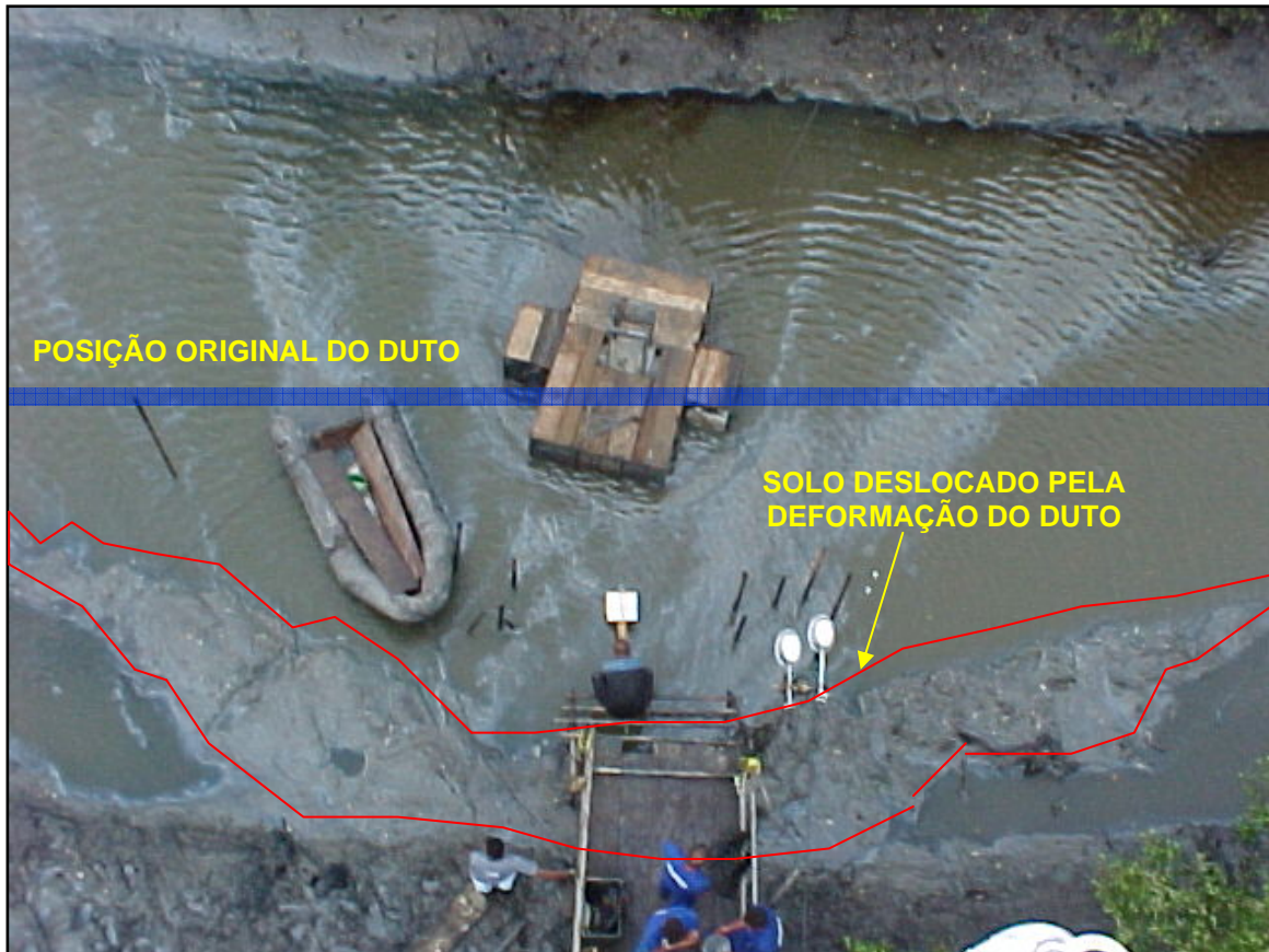
Figura 2.26 – Vista aérea do local da ruptura (PETROBRAS, 2000).
