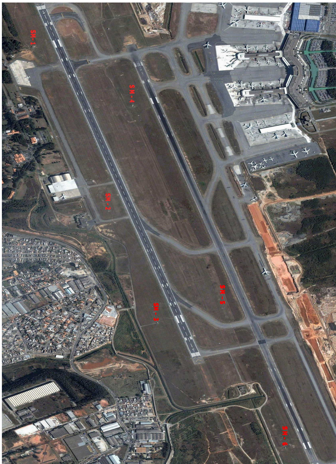
Figura 3.1 – Imagem das pistas do Aeroporto de Guarulhos, nela estão indicados seis sítios meteorológicos (SM) nos quais estão os instrumentos de medidas dos parâmetros meteorológicos. O SM-1 é, atualmente, o sitio principal. A obtenção da imagem foi na internet ( Google Maps ) e das informações sobre as localizações dos sítios pessoalmente com o ICEA.
