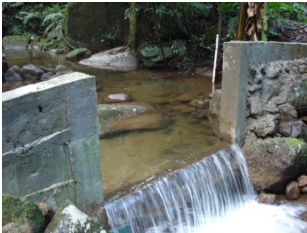
Figura 3.17 – Vertedouro no ponto 8 onde está instalado a sonda de monitoramento de nível do projeto HIDROCIDADES.
