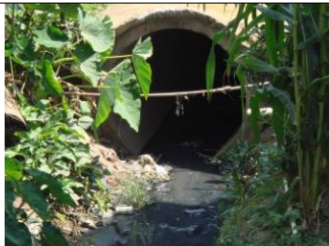
Figura 3.10 - Manilha canalizando o corpo hídrico a montante do Parque Aquático.
