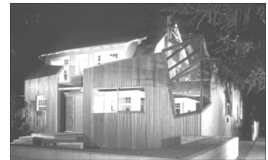
Figura 119 – Residência de Frank Gehry
