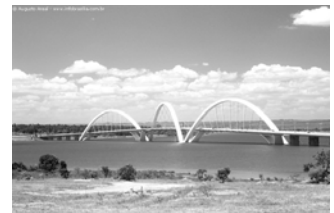
Figura 138 – Ponte JK, Brasília.
