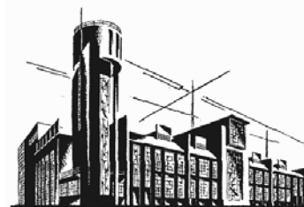
Figura 145 – Caixa d'água da fábrica Krasniy Gvozdiilshchik Chernikov, 1931.
