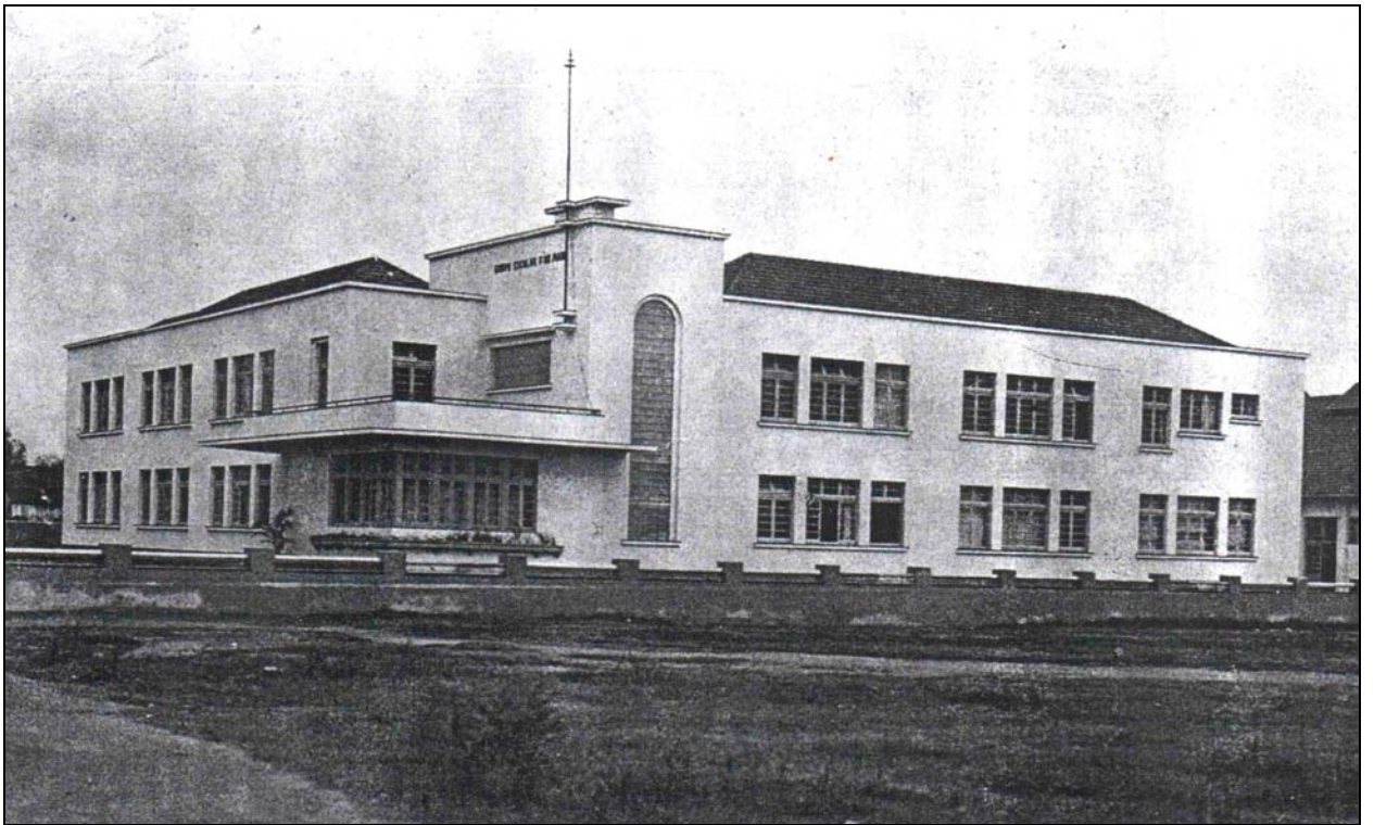
Foto 4 (Extraída: RBEP n. 8, fev./ 1945) – Edifício tipo zona urbana para 500 alunos, em cada turno de ensino (RS).
