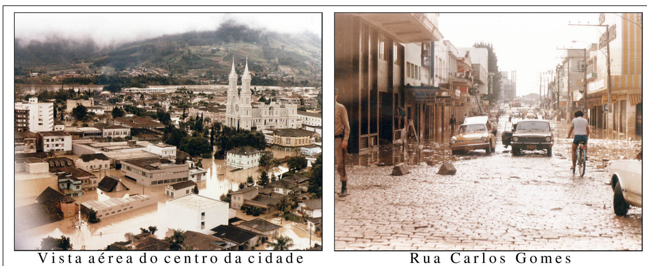
Figura 17: Imagens das enchentes ocorridas na década de 1980
