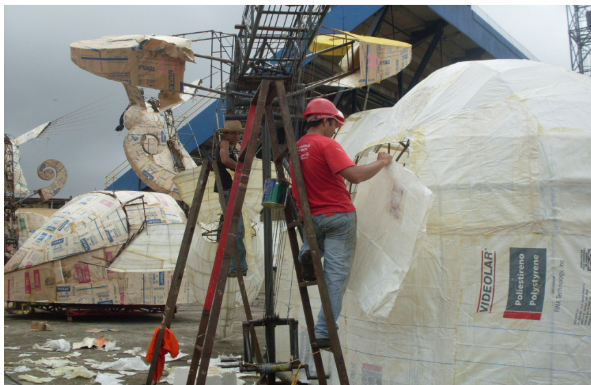
Figura 35 – Finalização dos trabalhos Fotografia: Leandro Bentes (2009)
