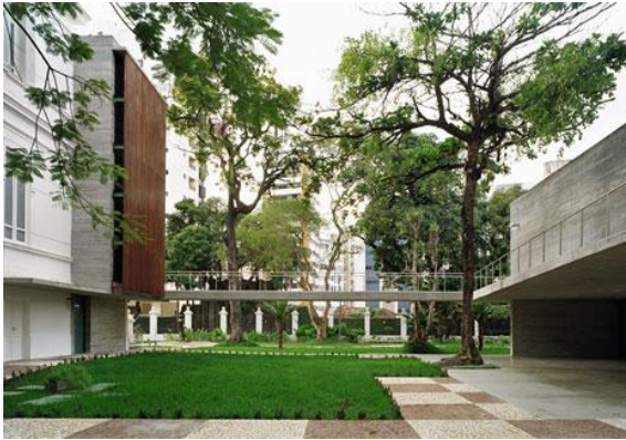
FIGURA 87 – [Museu Rodin, Salvador: passarela que une os dois blocos, conformando um pátio entre as edificações e mirante para a obra mais importante – A Porta do Inferno]
