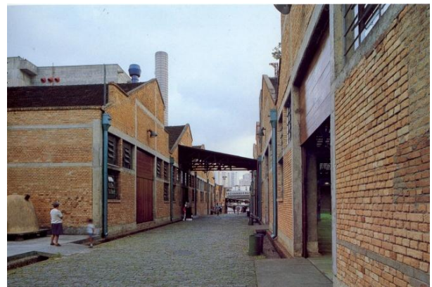
FIGURA 46 – SESC Pompéia, São Paulo: rua interna (antiga rua de serviço da antiga fábrica) ao longo da qual os galpões se abrem e se conformam num dos eixos articuladores do espaço
