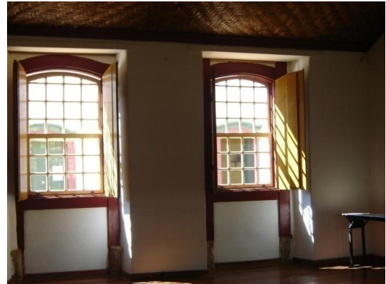
FIGURA 27 – [Parte interna da fachada frontal da sede do edifício com seus elementos construtivos (vergas e enquadramentos) preservados]
