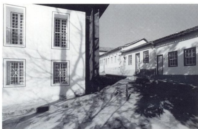
FIGURA 56 – Residência do Arcebispo de Mariana: manutenção dos ritmos das aberturas
