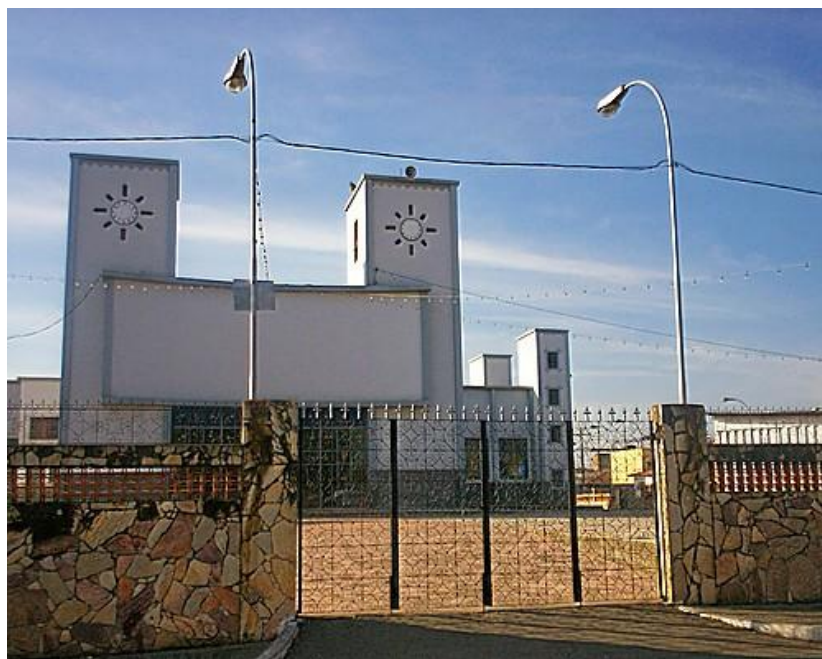
FIGURA 32 – [Nova Igreja de Matozinhos em São João del Rei, construída em 1975]
