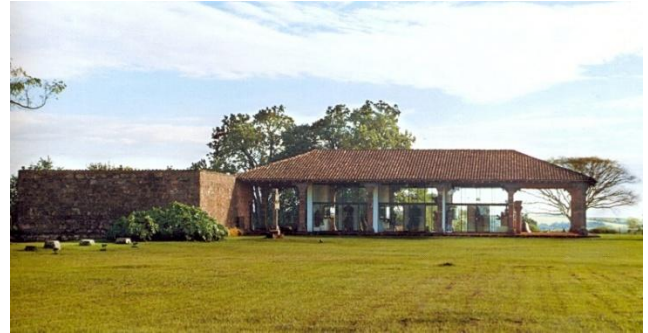
FIGURA 13 – O museu configurando-se como um pavilhão onde o vidro usado como vedação permite a fruição das peças escultóricas com a Catedral como cenário, se vista de norte para sul
