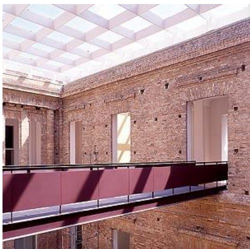
FIGURA 73 – [Pinacoteca de São Paulo: detalhe das clarabóias planas em estrutura metálica]
