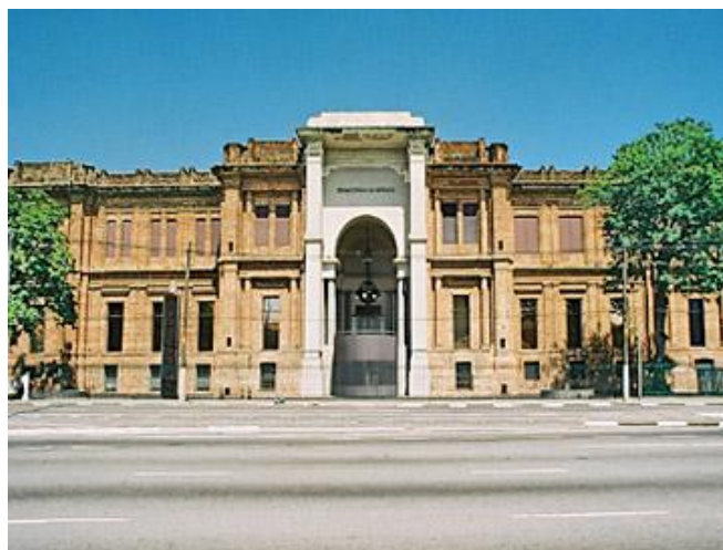
FIGURA 74 – [Pinacoteca de São Paulo: antiga fachada principal, na Av. Tiradentes]
