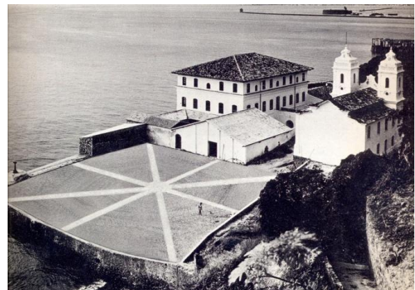
FIGURA 23 – Solar do Unhão, depois da restauração, em 1963
