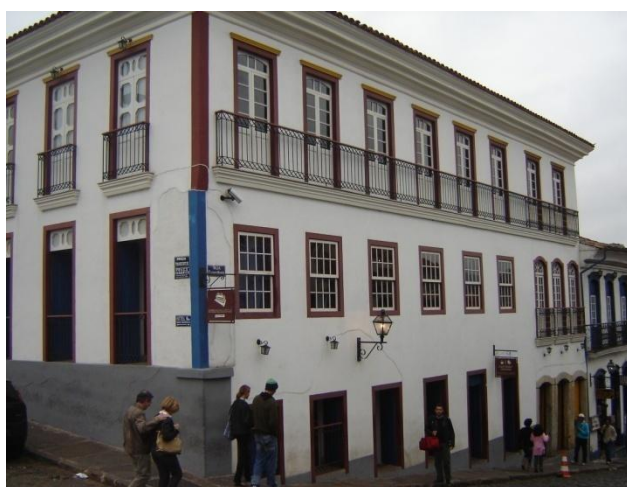
FIGURA 90 – [Parte externa do casarão, reconstruída igual à anterior]
