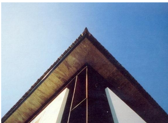
FIGURA 57 – Residência do Arcebispo de Mariana: estrutura metálica marcando os cunhais
