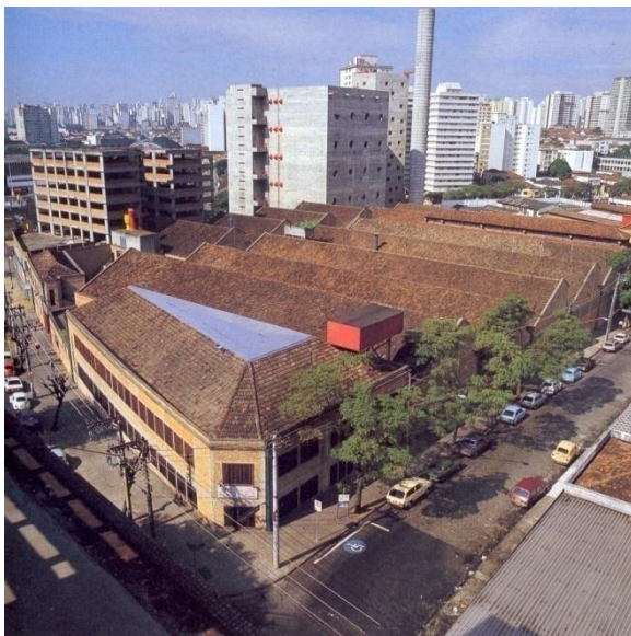
FIGURA 45 – SESC Pompéia, São Paulo: galpões da antiga fábrica cobertos por telhado tradicional de duas águas e telhas de vidro
