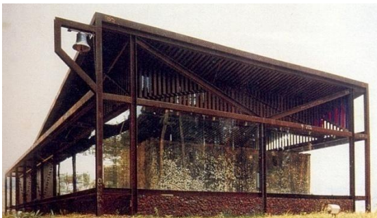
FIGURA 51 – [Capela de Santana ao Pé do Morro: estrutura metálica envolvendo a ruína]
