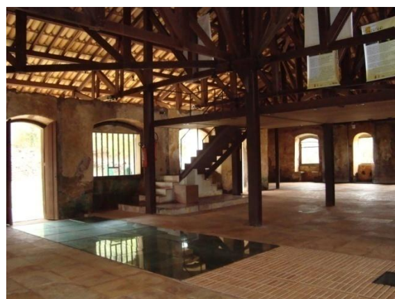
FIGURA 84 – [Sede da fazenda São José do Manso, Ouro Preto: estrutura da cobertura nova, independente, que permite a criação de um mezanino]
