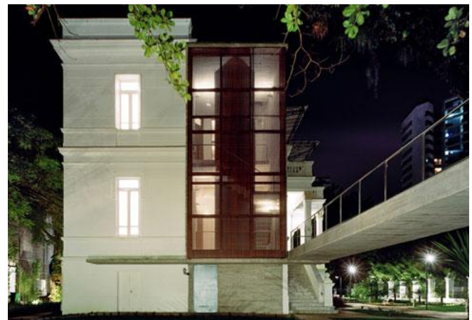
FIGURA 86 – [Museu Rodin, Salvador: intervenção na caixa de circulação vertical, "encaixada" no antigo edifício]
