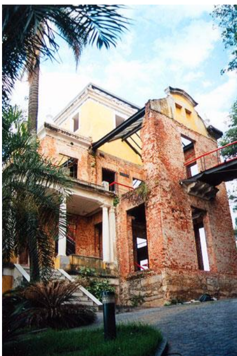
FIGURA 75 – [Parque das Ruínas, Rio de Janeiro: mirantes proporcionados pelos vãos, que permanecem abertos]
