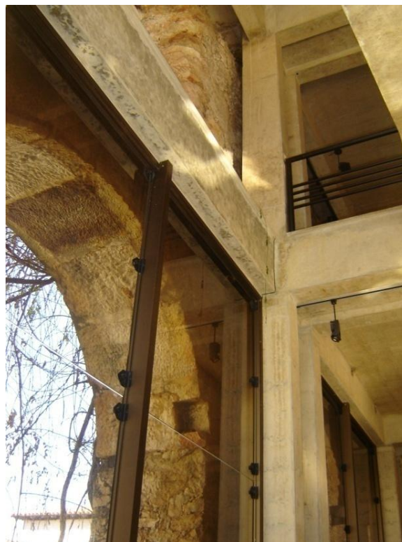
FIGURA 64 – [Vedação e estrutura independentes das paredes de pedra originais, obtendo-se uma leitura clara dos dois organismos]
