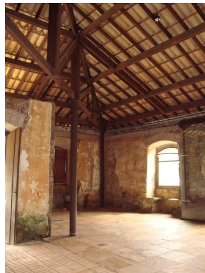
FIGURA 82 – [Sede da fazenda São José do Manso, Ouro Preto: estrutura independente da cobertura e paredes sem reforma ou intervenção]
