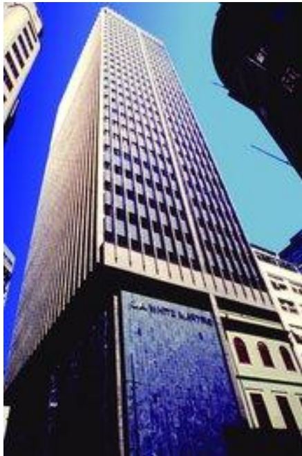
FIGURA 39 – [“Arranha-céu com sobrado”, sede da White Martins, construído pela Pontual Arquitetura entre 1972-1975]
