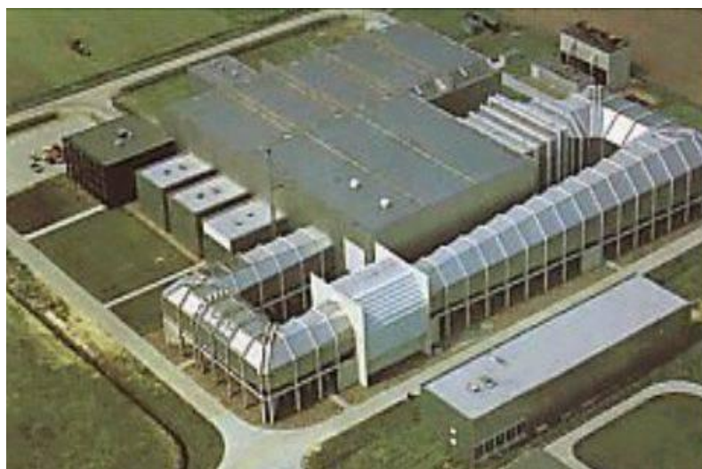
Figura 3.7 – Túnel de vento DNW ( Deutsch-Niederisch Windkanaal ) de circuito fechado, localizado na Holanda.(DNW, 2009)
