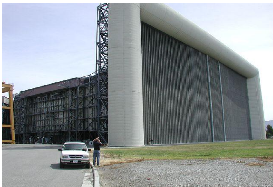
Figura 3.25 – Colméia retificadora na entrada do túnel de vento da NASA (NASA, 2008)
