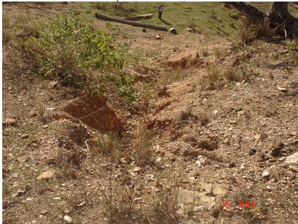
Figura 5.22 – Processo erosivo nas encostas, associado á declividade acentuada e a ausência de cobertura vegetal. (Fonte: Levantamento de campo Julho de 2006.
