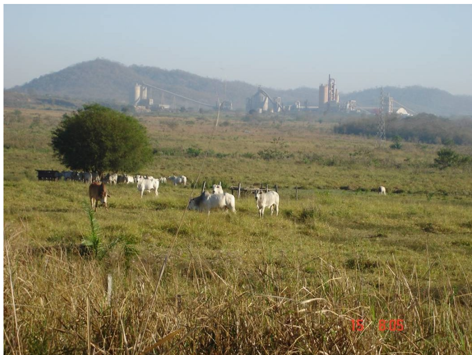
Figura 5.0- Área da bacia afluente do Córrego Campina: solo utilizado para pecuária extensiva e ao fundo as instalações de uma fábrica de cimento. (Coordenadas UTM: 0529814; 7733504 –Alt. 173 m). Fonte: Levantamento de campo Julho de 2006.
