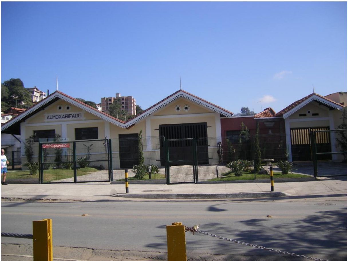
FOTO 04 – Parte da fachada do Almoarifado da antiga Estação Ferroviária de Pedro Leopoldo Fonte: Acervo pessoal.
