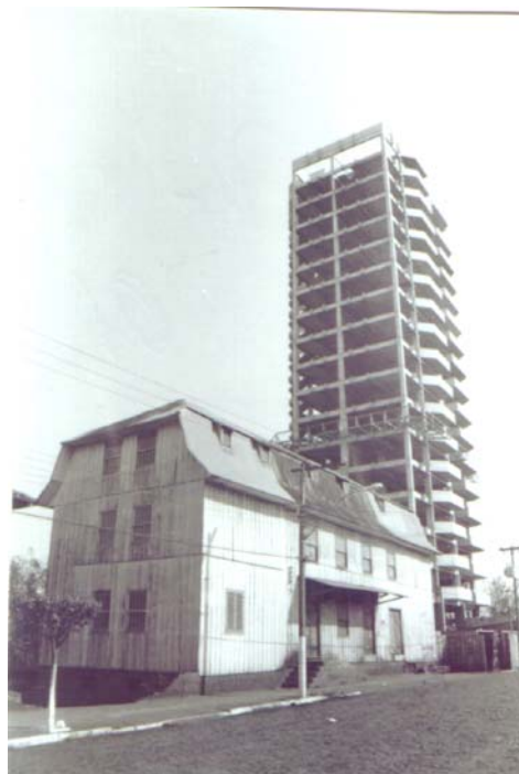
Edifício em construção nos anos 80 Fonte: Jornal O Celeiro
