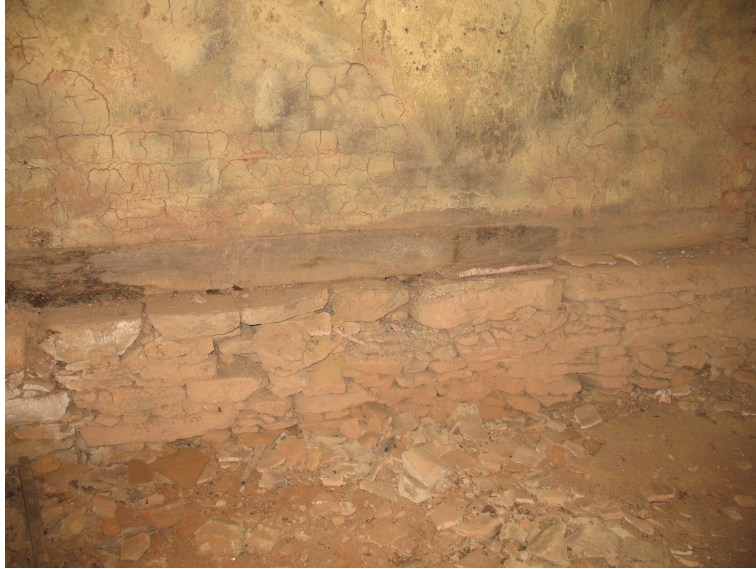
Imagem III: Detalhe da base da parede interna da senzala da Fazenda Santa Clara, Valença.
