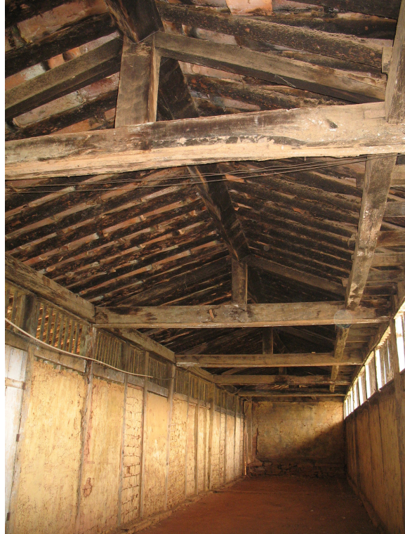
Imagem V: Detalhe das aberturas superiores, do telhado e do piso de terra batida do interior da senzala da Fazenda Santa Clara, Valença.
