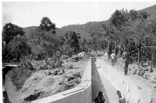
Figura 5 – Fotografia P&B das obras de saneamento do Rio da Bulha (Florianópolis) em 1922. (IHGSC).
