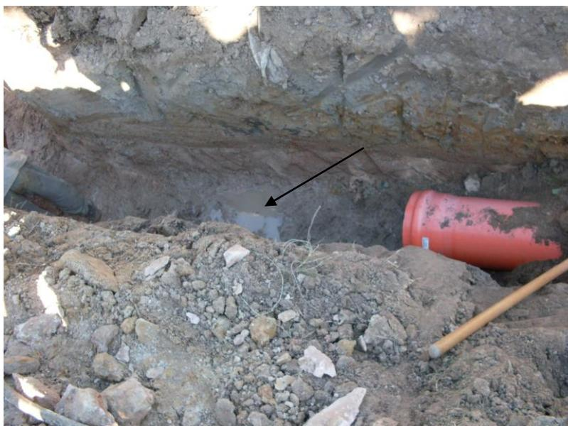
**Figura 10:** Perfuração sobre a Formação Marília para passagem de tubulação do Sistema de Afastamento de Esgoto. Nota-se o afloramento do aquífero freático.
