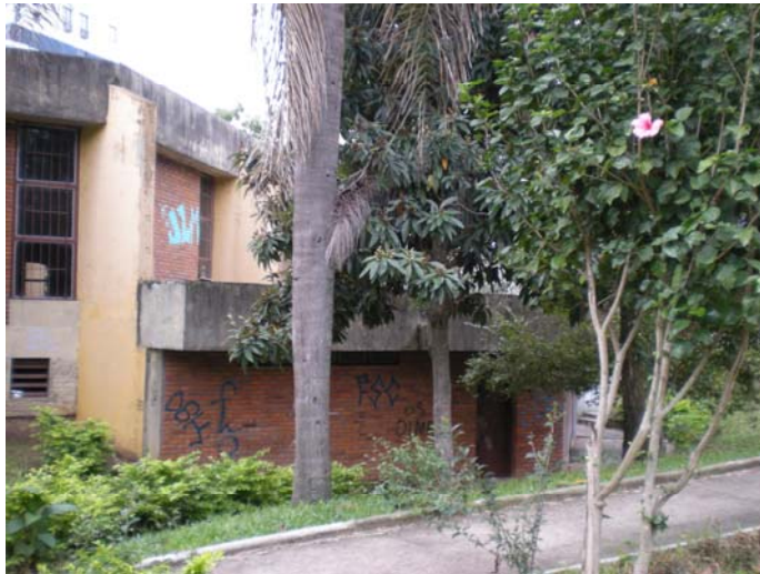
FIGURA 27: Imagem instalações do Grupo Terceira Idade.
