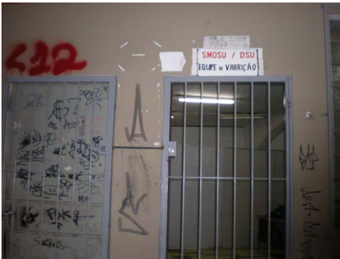
FIGURA 25: Imagem instalação da Equipe de Varrição
