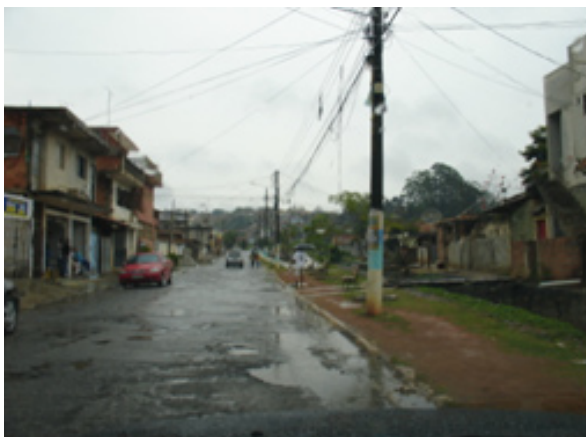
Imagem 07 - Periferia da cidade de Itapeceirica da Serra, São Paulo: postes muito distantes entre si, alguns sem luminárias e outros com luminárias abertas de baixo rendimento e lâmpadas de baixa potência.
