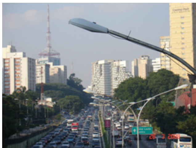
Imagem 17 - Avenida 23 de Maio, bairro do Paraíso, São Paulo, com postes e luminárias desalinhados e luminárias nas mais variadas inclinações.
