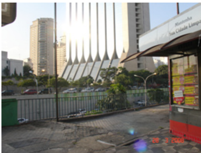
Imagem 27 - Luminárias com as lâmpadas acesas durante o dia desperdiçando energia e ajudando a poluir o meio ambiente na Av. 23 de Maio, bairro do Paraíso, São Paulo. Fonte: Isac Roizenblatt, 28/03/2008
