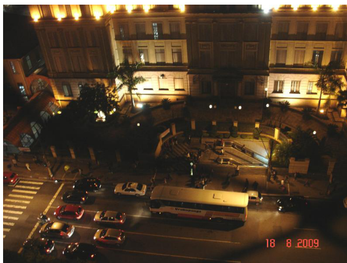
Imagem 102 - Projetores da fachada do Shopping. Fonte: Isac Roizenblatt, 2009.
