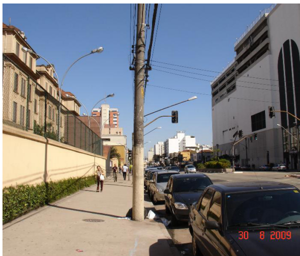
Imagem 92 - Iluminação complementar do colégio, servindo à calçada.
