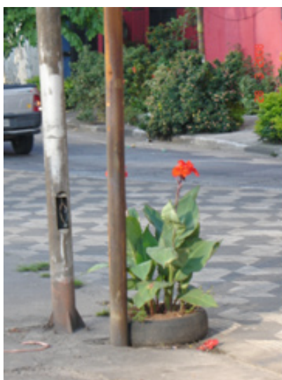
Imagem 12 - Cruzamento sobre a Avenida 23 de Maio com a Rua Tutóia, bairro do Paraíso, São Paulo, onde se observa postes enferrujados, sujos e incompletos pela ausência da tampa de passagem da fiação.
