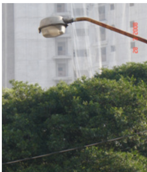
Imagem 18 - Luminária iluminando a copa da árvore, com sua lâmpada caída dentro da luminária ou muito abaixada causando ofuscamento à noite na Praça do Santíssimo Sacramento, Bairro do Paraíso, São Paulo.
