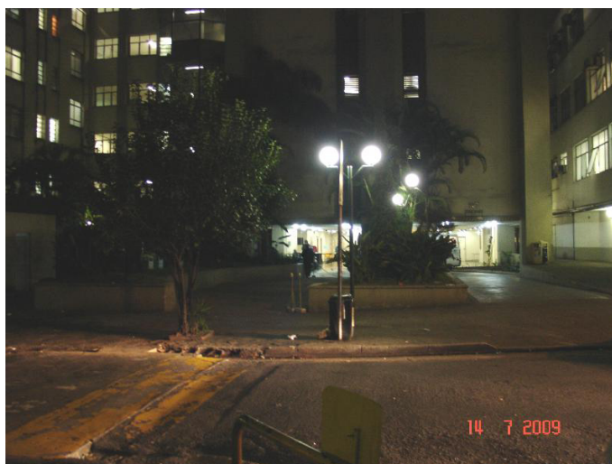
Imagem 66 - Frente do hospital, porta principal, travessia em nível.
