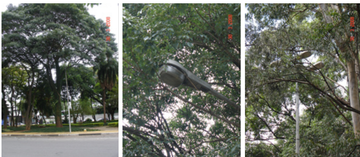
Imagens 23, 24 e 25 - Luminárias cercadas por folhas das copa das árvores na rua Curitiba, bairro do Paraíso e no Parque do Ibirapuera, São Paulo.
