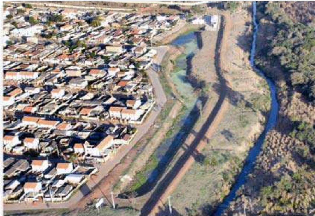
FIGURA 21 - DIQUE E BACIA DE AMORTECIMENTO NA VILA ZUMBI FONTE: COHAPAR (2008)
