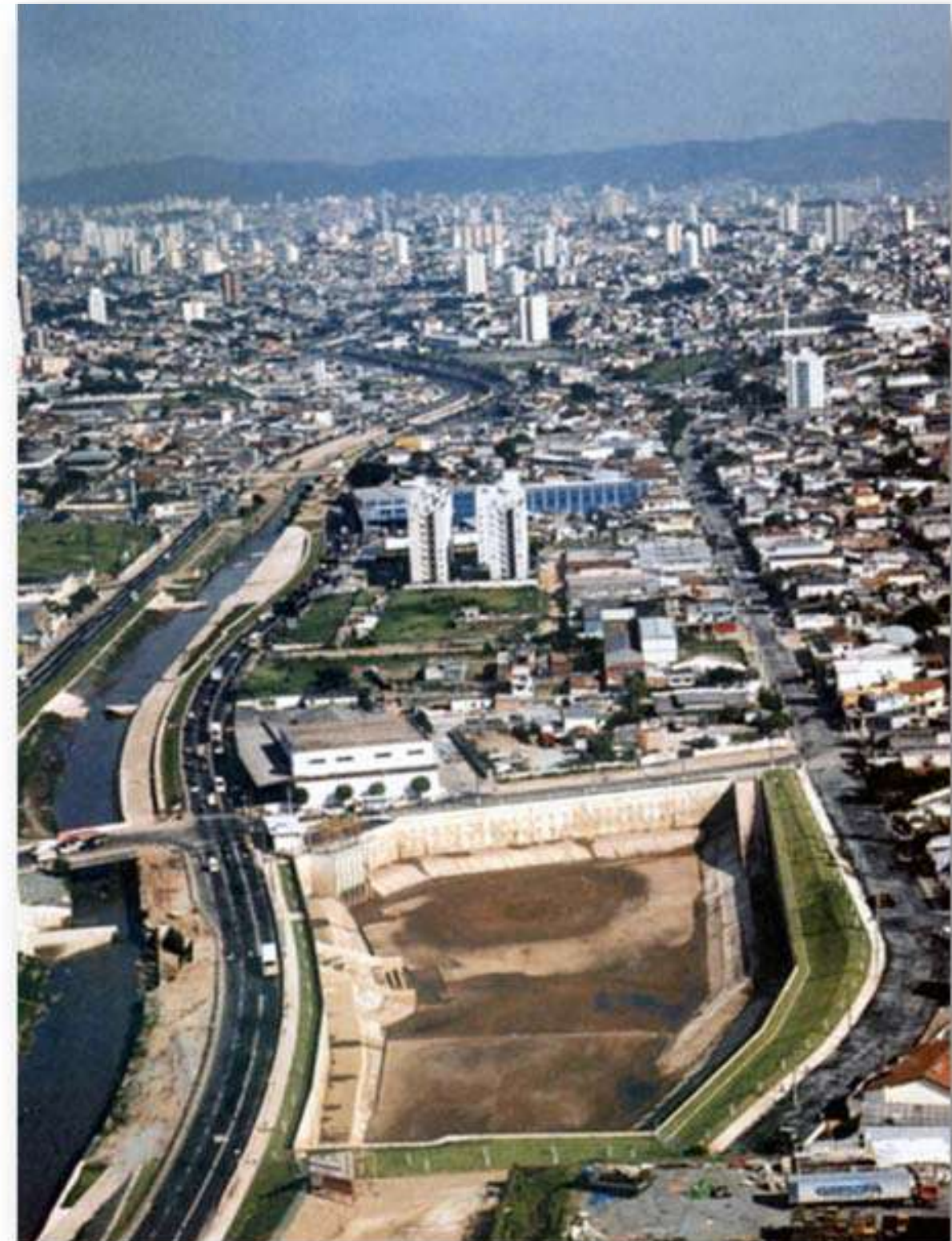
FIGURA 16 – RESERVATÓRIO DE AMORTECIMENTO DAS CHEIAS NA BACIA DO RIO ARICANDUVA, SÃO PAULO FONTE: HIDROSTUDIO ENGENHARIA (2002)
