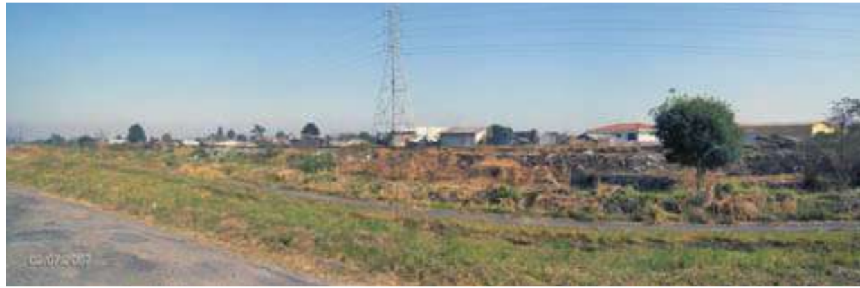
FIGURA A - OCUPAÇÃO IRREGULAR NA FAIXA DE DOMÍNIO DA LINHA FÉRREA FONTE: O AUTOR (2007)
