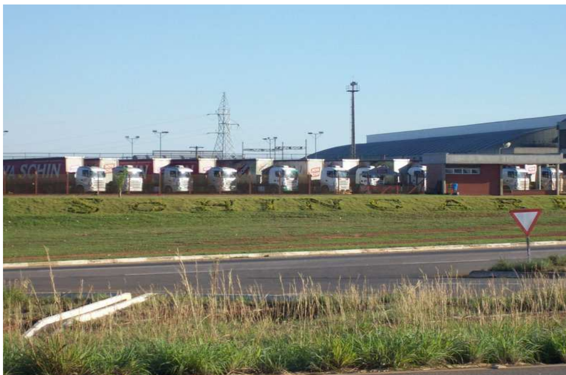
Figura7: Vista da Indústria Schincariol
