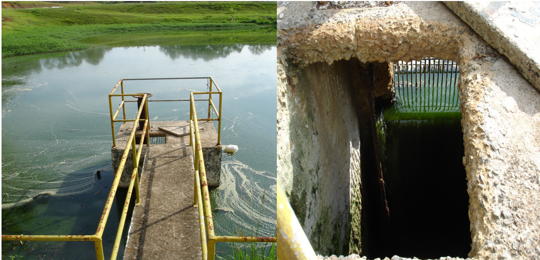
Figura 6 – Ponto de coleta de efluente na ETE-Cecap
