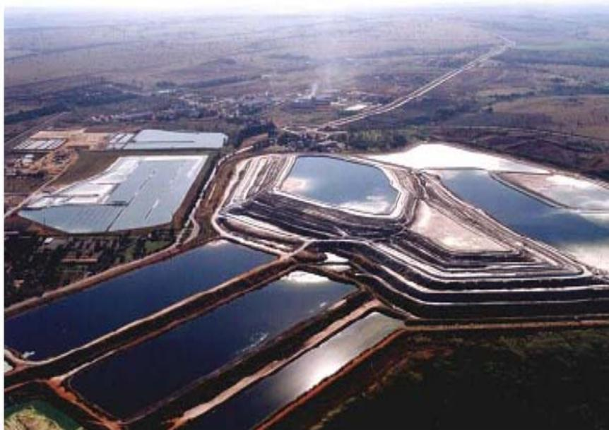
FIGURA 3.5 - Modo de armazenamento do fosfogesso
