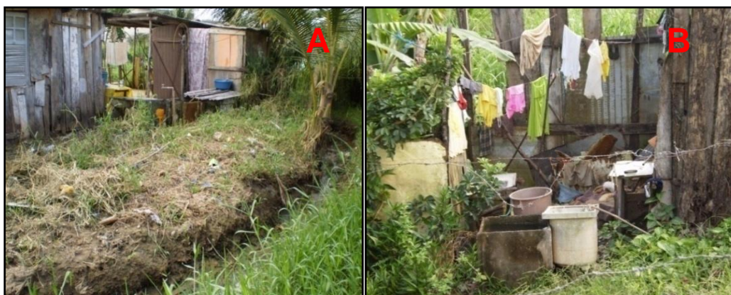
Figura 20: Fotografias das condições de armazenamento de água nos domicílios pesquisados do bairro Teotônio Vilela – Ilhéus (BA) (A) Reservatório sem tampa, e ao lado da vala do esgoto e (B) Reservatório sem a tampa
