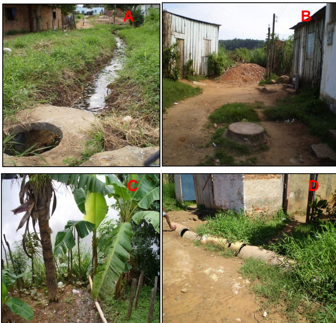
Figura 24: Fotografias mostrando a destinação final dos esgotos, lançados no entorno do manguezal (área de estudo), do bairro Teotônio Vilela – Ilhéus (BA). (A) Esgoto a céu aberto (B) Rede coletora de esgoto (C) Tubulação direta para o rio (D) Manilhas jogando esgoto para o mangue
