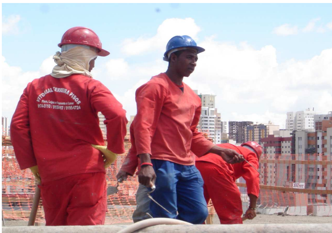
Foto 7 e 8 – Trabalhadores de empresas prestadoras de serviço especializado em canteiro de obras de Águas Claras
