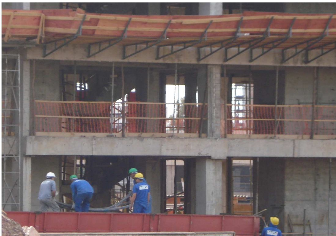
Foto 6 – Operários trabalhando em canteiro de obras de Águas Claras
