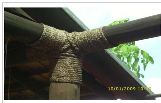
Figura 59: Parque Naturalístico Mangal das Garças: Estrutura de telhado fixada com cordas. Fonte: Arquivo particular do autor, 2009.
