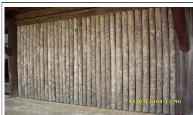
Figura 57: Parque Naturalístico Mangal das Garças: Parede de troncos de árvores. Fonte: Arquivo particular do autor, 2009.
