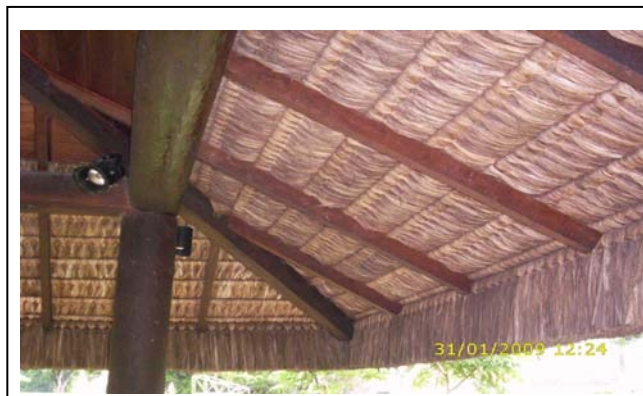
Figura 58: Parque Naturalístico Mangal das Garças: Cobertura em palha. Fonte: Arquivo particular do autor, 2009
