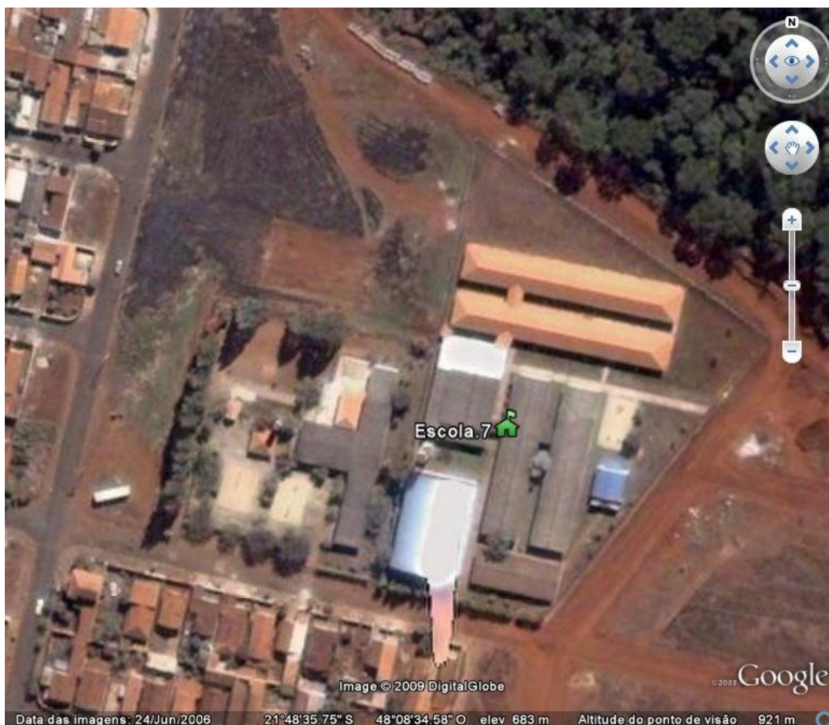
Figura 8. Vista aérea da Escola.7. Imagem de foto de satélite proveniente de arquivo exportado do software gratuito Google Earth™, versão 5, em março/2009.
