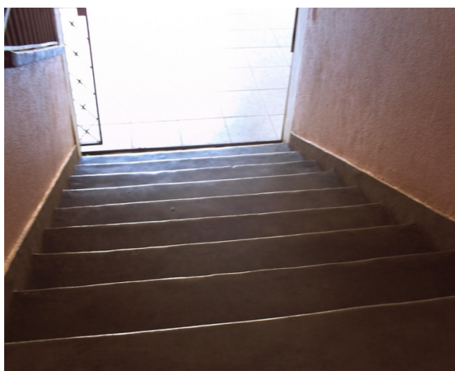
Figura 4: Escadas de acesso ao 2º pavimento Fonte: Arquivo da autora.
