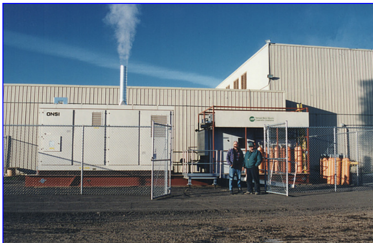
Figura 3-8 - Pilhas de ácido fosfórico instaladas no Alasca. O sistema gera 1 MW
