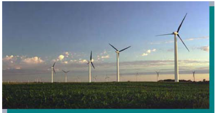
(b) Grande Porte (250 kW - 2MW) - Fazendas Eólicas e Geração Distribuída
